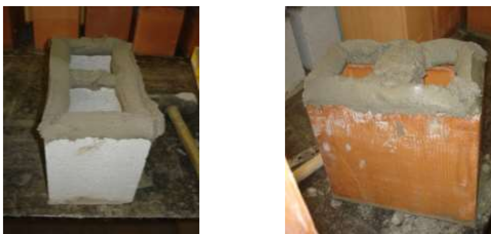
Figura 21. Todas as paredes argamassadas.
