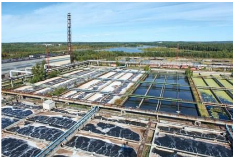
Foto 1 - Estação de tratamento de esgoto (Fonte: CEDAE, 2008)
