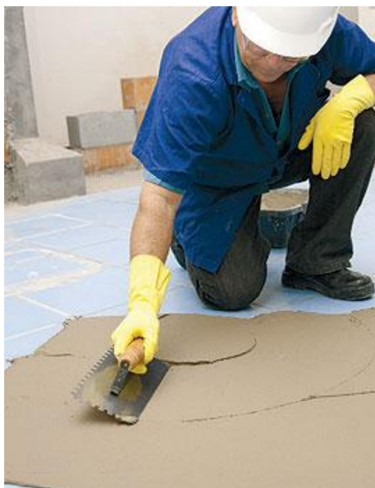
Figura 18 – Aplicação da argamassa colante
