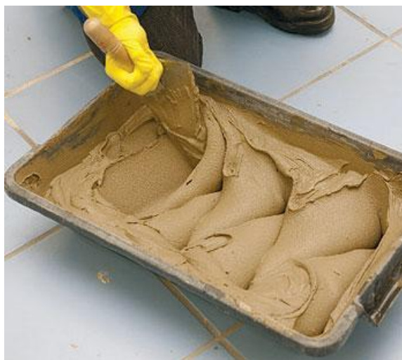
Figura 17 – Preparação da argamassa colante
