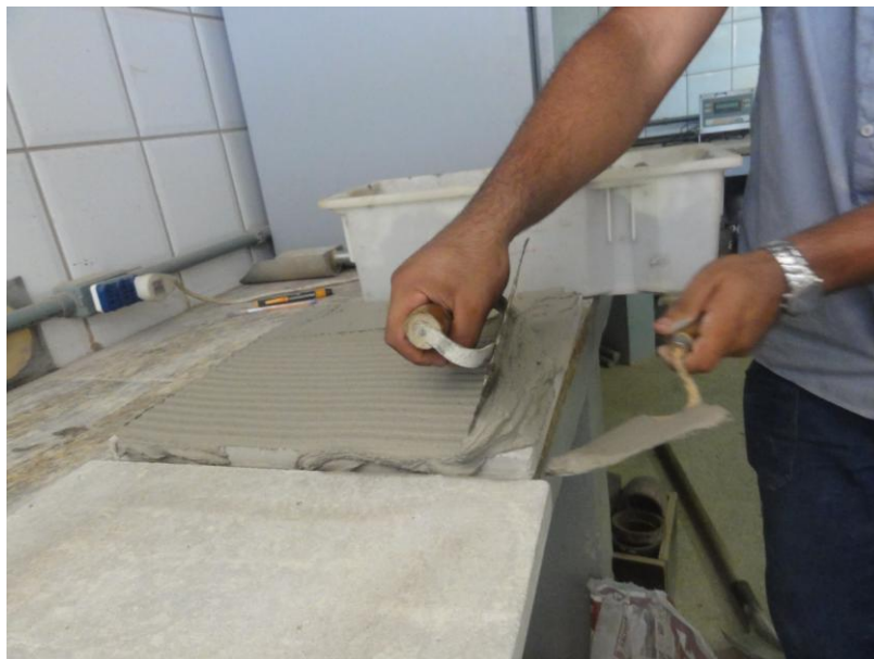
Figura 38 – Argamassa de assentamento do piso de referência (Placa Base) sobre o substrato padrão (Granilite)..
