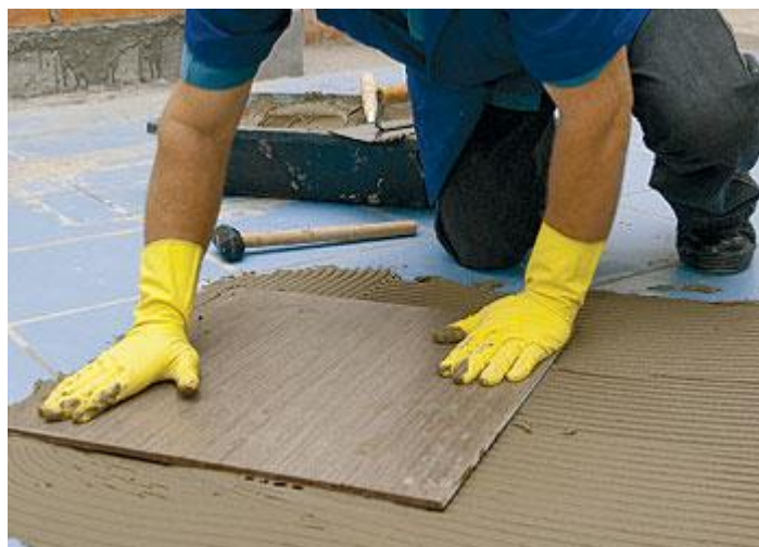
Figura 20 – Assentamento da placa – etapa manual
