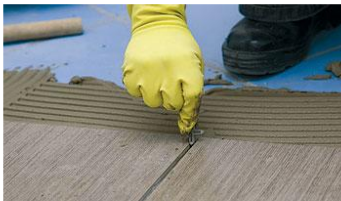
Figura 23 – Aplicação de espaçadores
