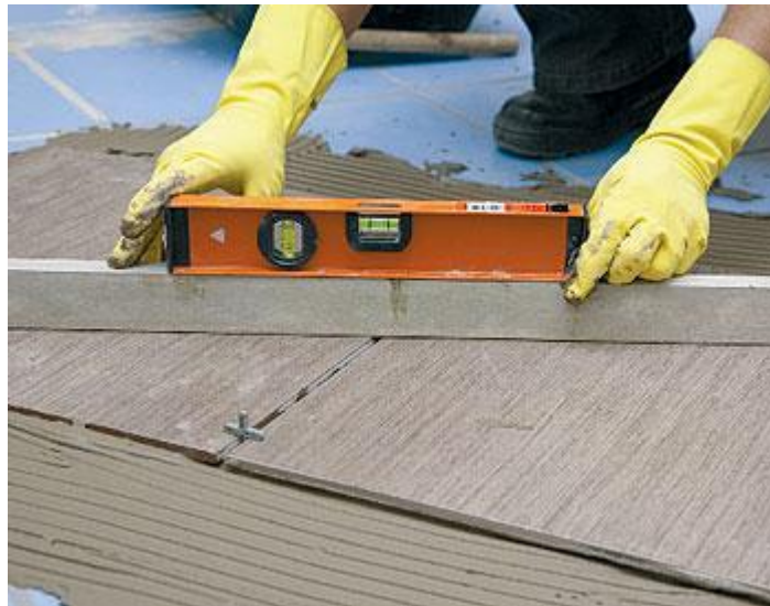
Figura 24 – Verificação do nivelamento
