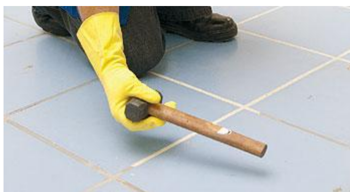
Figura 15 – Verificação do piso original
