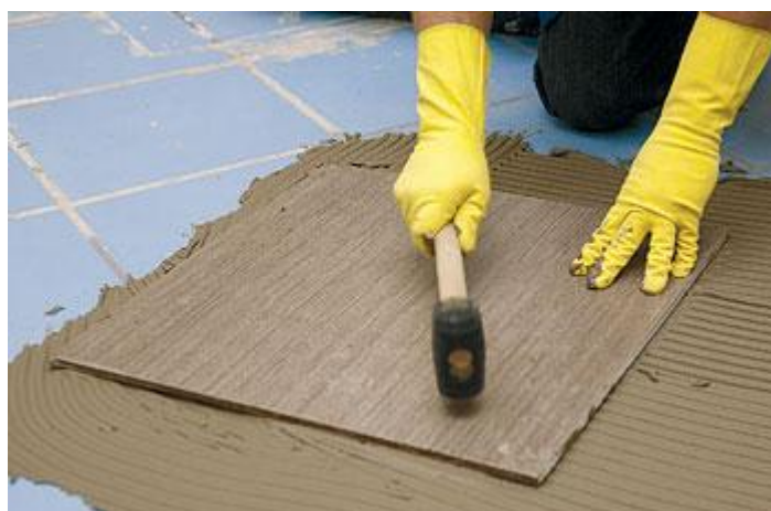
Figura 21 – Assentamento da placa – etapa com martelo de borracha
