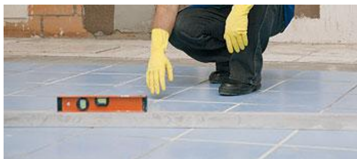
Figura 14 – Verificação da planicidade.
