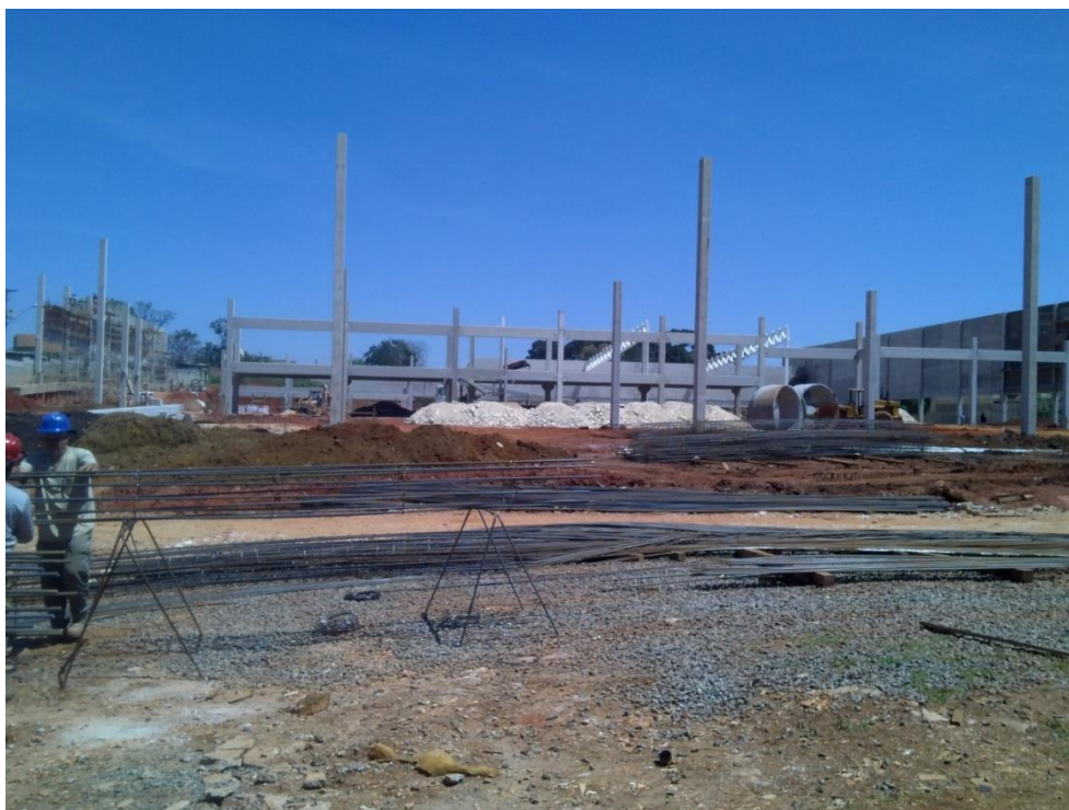
Figura 26: Foto Estrutura Pré-moldado (10/10/2014) Fonte: SUPERMERCADOS CONDOR
