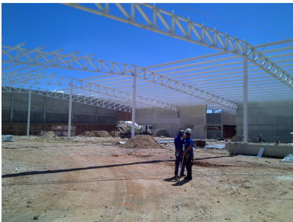
Figura 25: Foto Estrutura Metálica (17/11/2014) Fonte: SUPERMERCADOS CONDOR
