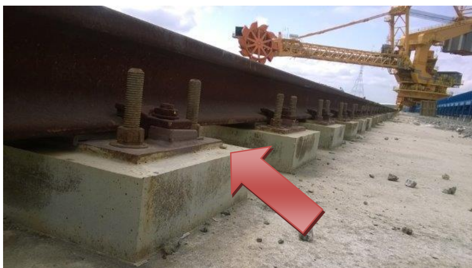
Foto 3-Emcecrete EP para fixação de trilhos no Porto Sudeste.
