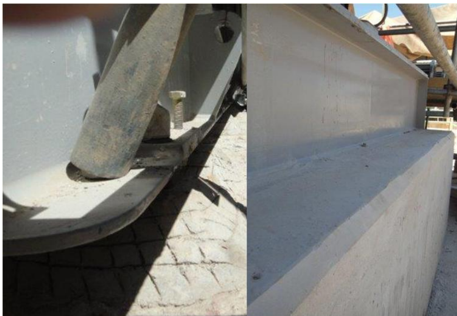
Foto 4-Antes e depois da aplicação do Emcecrete EP na Comperj.
