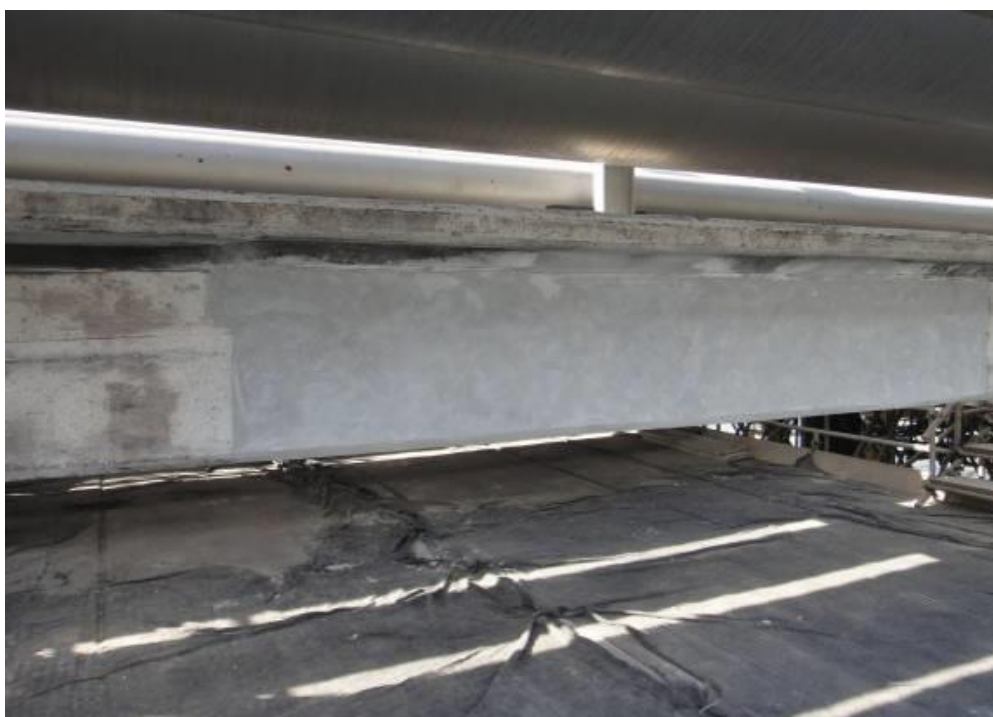
Foto 1-Emckrete EP no píer São Sebastião.
