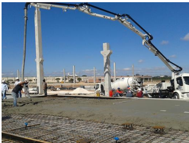
Figura 52 – Caminhão bomba em atividade
