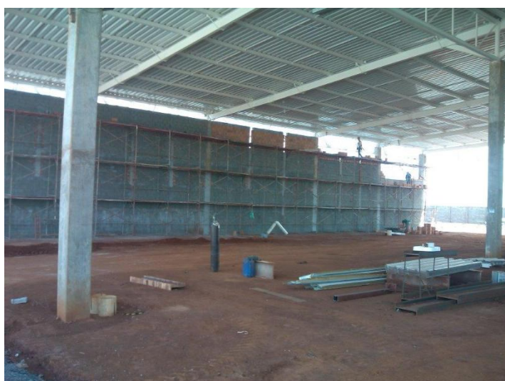
Figura 47 – Galpão antes da aplicação do concreto
