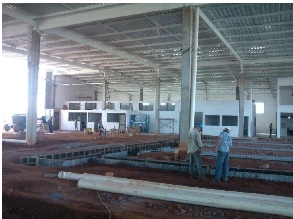
Figura 49 – Galpão antes da aplicação do concreto Fonte: Acervo do grupo – Coleta de dados
