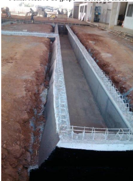
Figura 48 – Galpão antes da aplicação do concreto Fonte: Acervo do grupo – Coleta de dados
