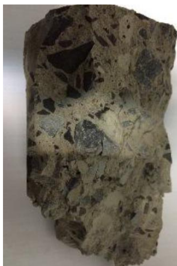
Figura 64 – Amostra de concreto coletada para reconstituição de traço Fonte: Laudo pericial
