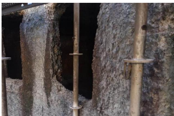
Foto 5 – Parede mais interna da EEE Pinheiros
