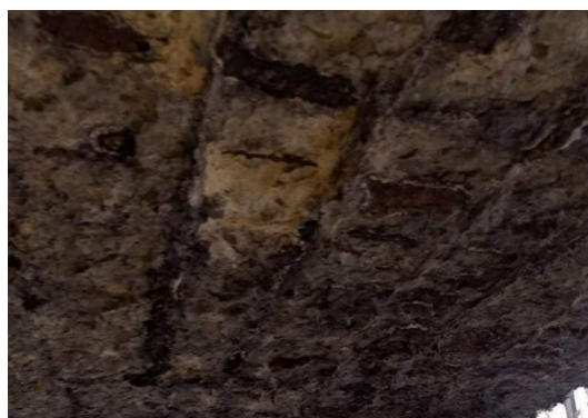
Foto 4 – Condição da laje superior da estrutura
