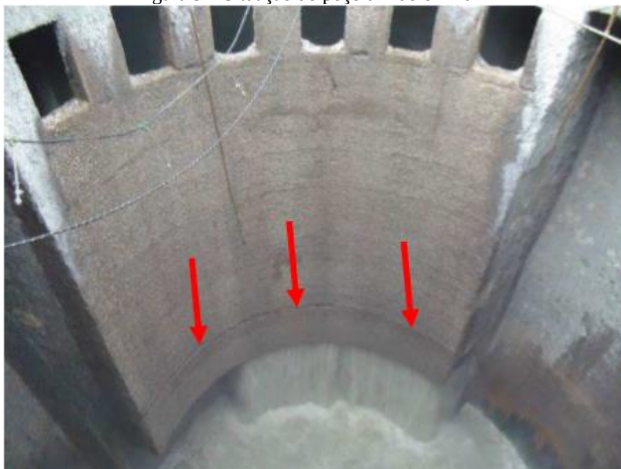
Figura 9 – Situação do poço úmido em 2014
