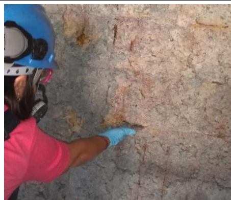
Foto 2 – Condição da parede do vertedouro
