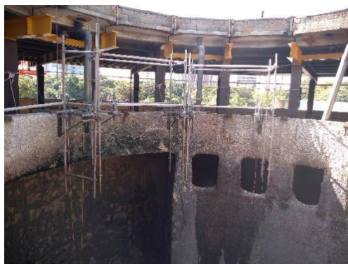
Foto 6 – Vista interna da EEE Pinheiros
