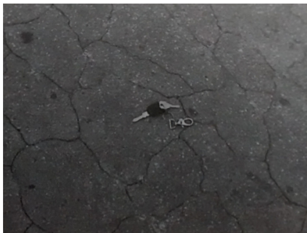
Figura 04 – Trincas em bloco (SILVA, 2008)
