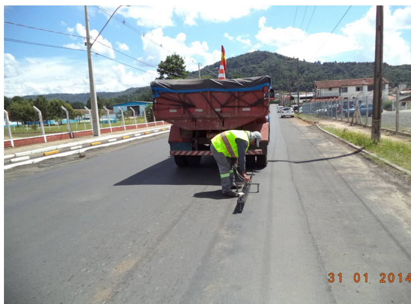
Figura 31 – Ensaio sendo realizado. (PMPU, 2014)
