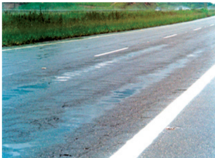
Figura 08 – Afundamentos (BERNUCCI, et al , 2010)
