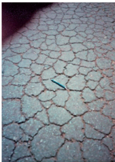
Figura 03 – Trinca Couro de Jacaré (BERNUCCI, et al , 2010)
