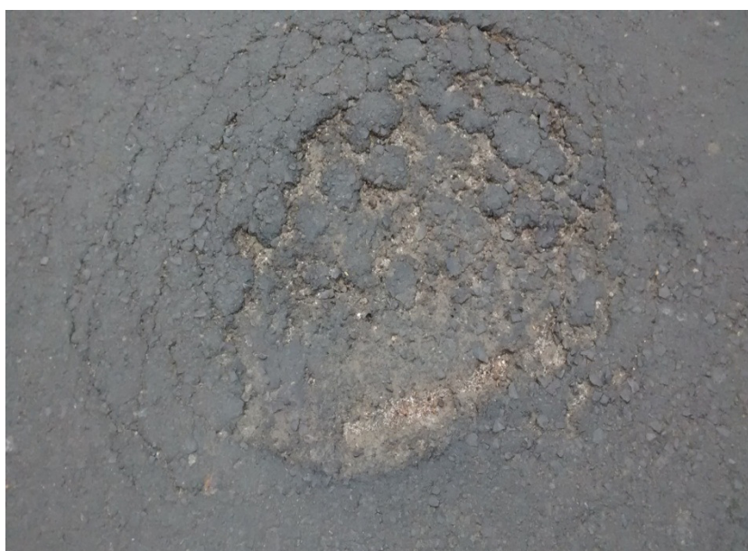
Figura 24 – Panela em formação
