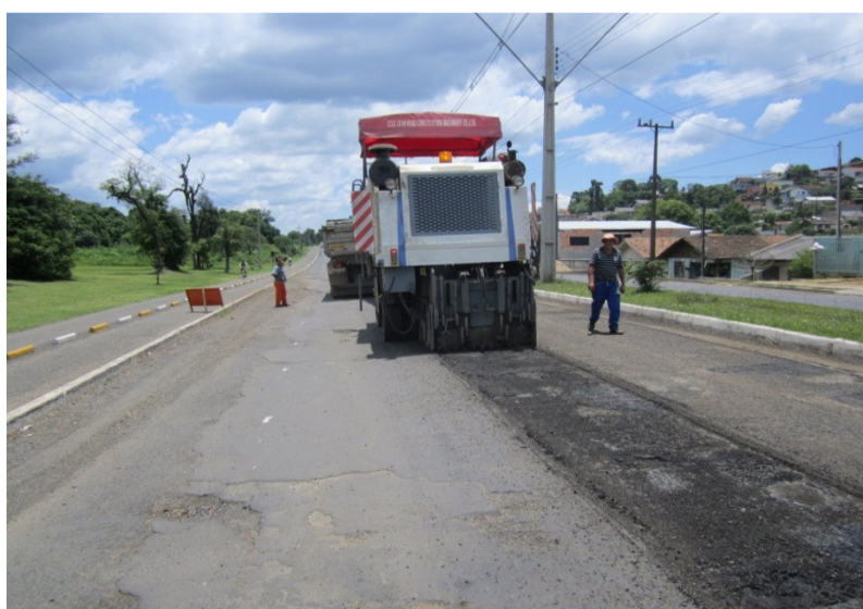
Figura 19 – Fresagem sendo realizada (PMPU, 2013)
