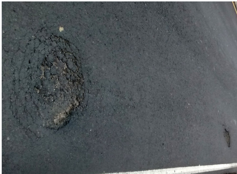
Figura 23– Duas primeiras panelas do trecho.
