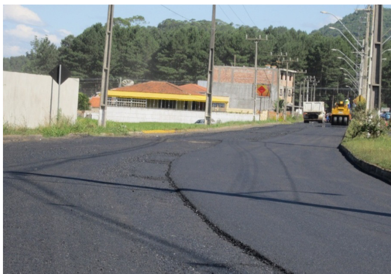
Figura 20 – Aplicação de nova capa (PMPU, 2013).
