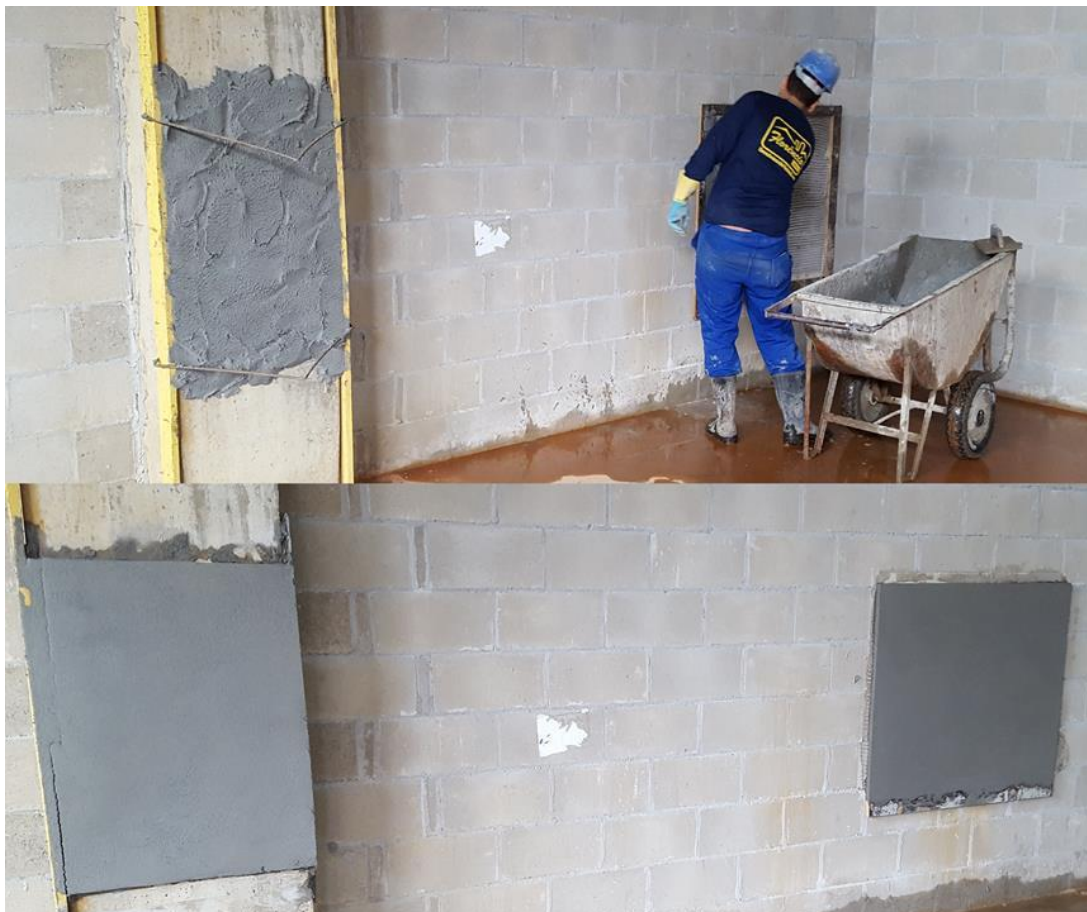
Fig. 05 - Paredes revestidas que irão curar por 28 dias para a execução dos ensaios de arrancamento
