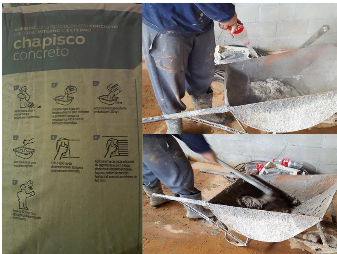
Fig. 03 - Instruções do fabricante e procedimento de mistura da argamassa de chapisco
