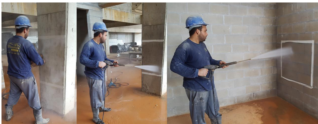
Fig. 02 - Tratamentos de lixamento e lavagem dos substratos
