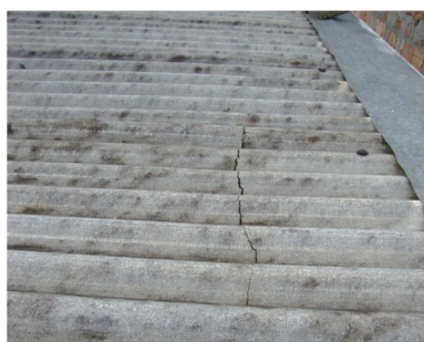
Foto 6 : Telha trincada
