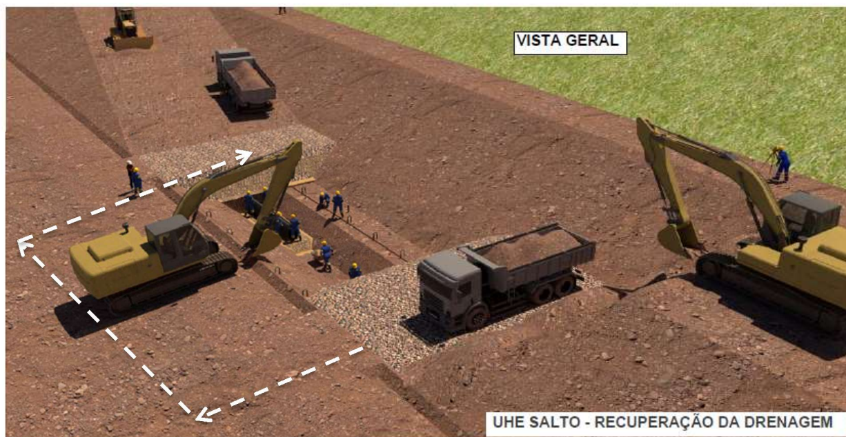
Figura 19 – Detalhe do avanço das atividades
