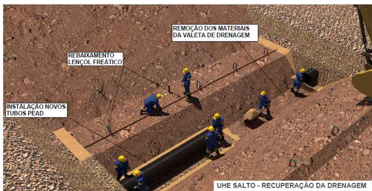
Figura 17 – Ilustração da célula escavada e instalação de tubo de PEAD sobre berço de brita e areia
