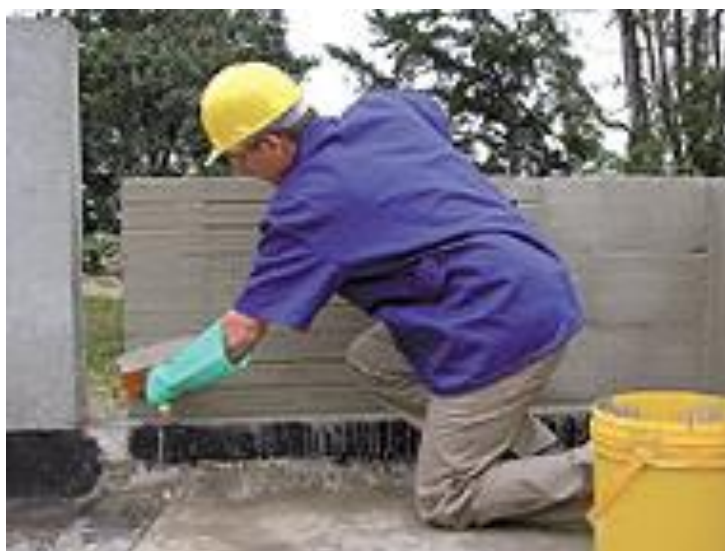
Figura 7 - Argamassa Polimérica (FERREIRA, 2012).
