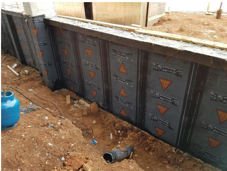
Figura 12 - Manta Asfáltica (do autor, 2016).
