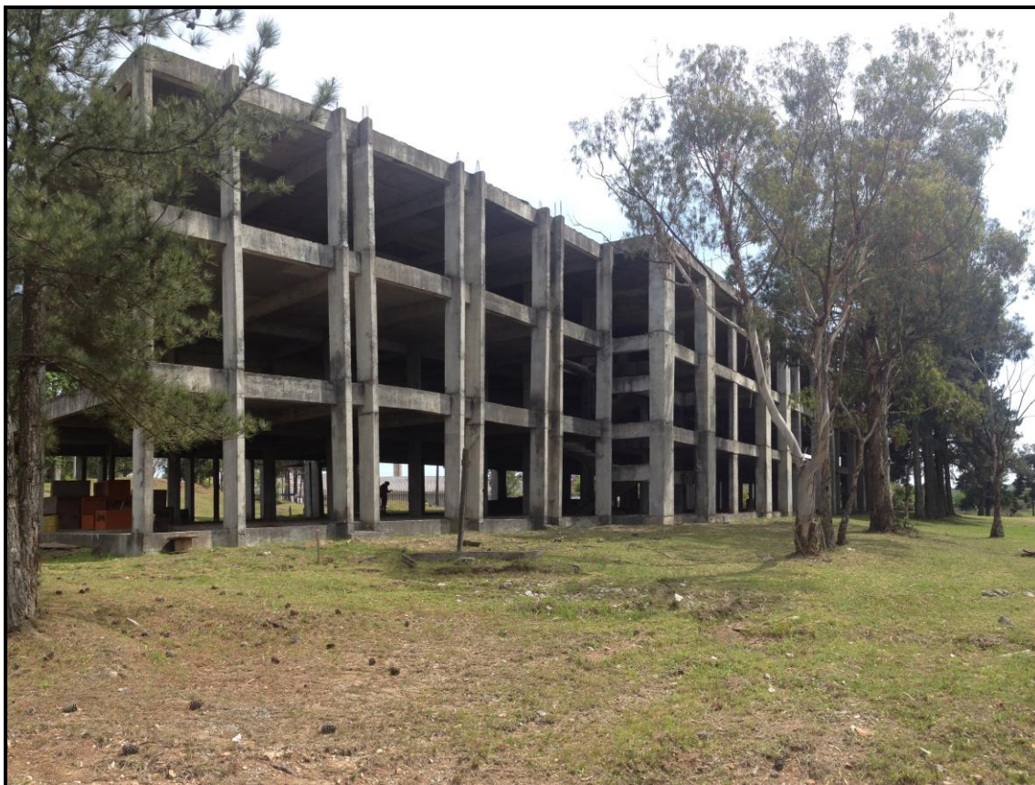
Figura 2 - Panorâmica da Estrutura
