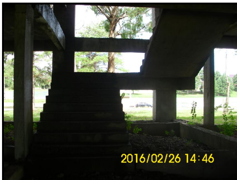
Foto 55 - TÉRREO/BALDRAMES - Aspecto geral da estrutura da escada.
