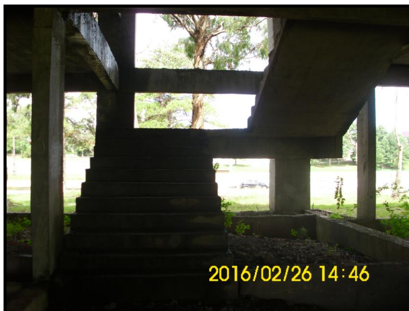
Foto 53 - TÉRREO/BALDRAMÉS - Aspecto geral da estrutura da escada.
