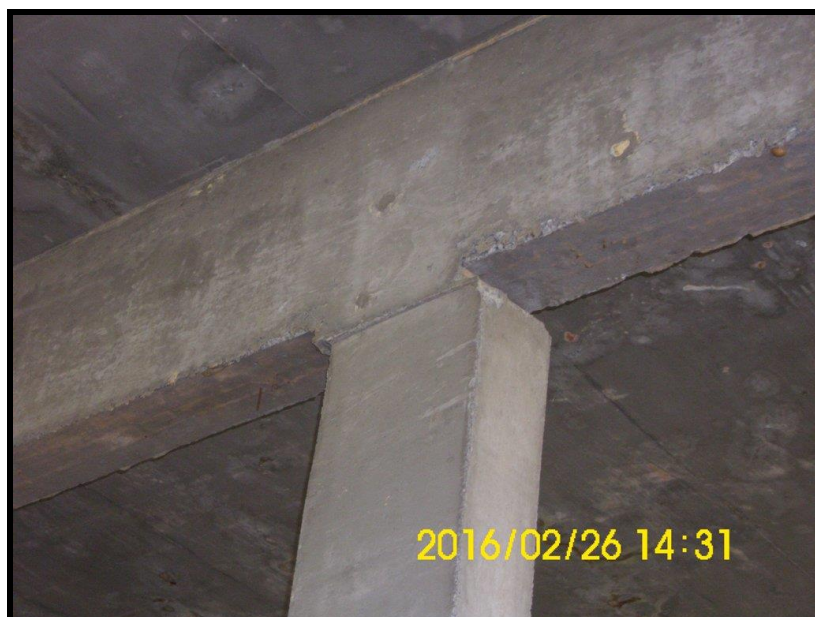
Foto 39 - 1º PAVIMENTO - Nicho de concretagem.
