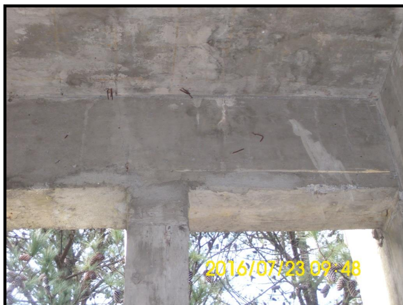
Foto 157 - 3º PAVIMENTO - Reparos em viga.
