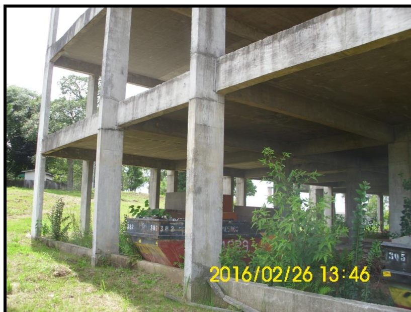
Foto 3 - TÉRREO/BALDRAMES - Aspecto geral da fachada lateral esquerda.
