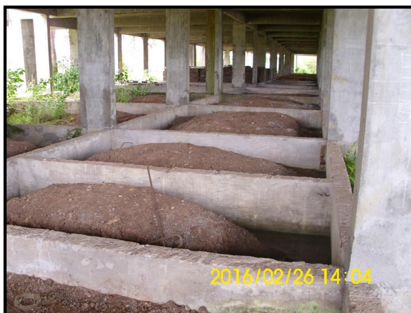
Foto 20 - TÉRREO/BALDRAMES - Aspecto geral da estrutura.
