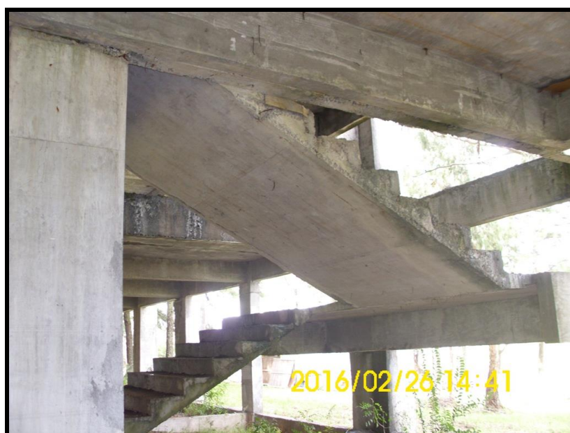
Foto 50 - TÉRREO/BALDRAMES - Aspecto geral da estrutura da escada.
