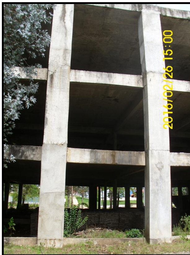
Foto 67 - 1º PAVIMENTO - Aspecto geral da fachada dos fundos.
