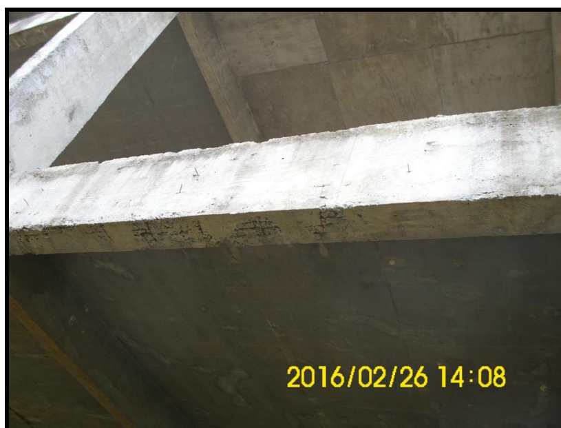
Foto 24 - 1º PAVIMENTO - Viga com nichos de concretagem.
