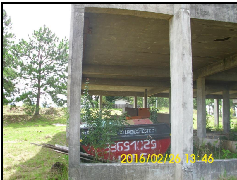
Foto 1 - TÉRREO/BALDRAMES - Aspecto geral da fachada frontal. Detalhe para trecho à esquerda.
