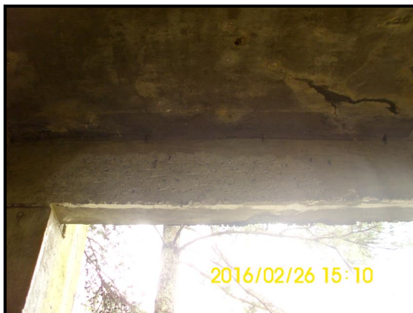
Foto 71 - 1º PAVIMENTO - Reparo em viga.
