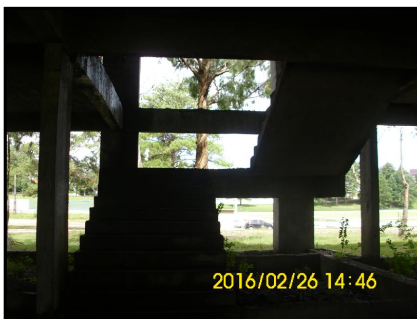
Foto 54 - TÉRREO/BALDRAMÉS - Aspecto geral da estrutura da escada.
