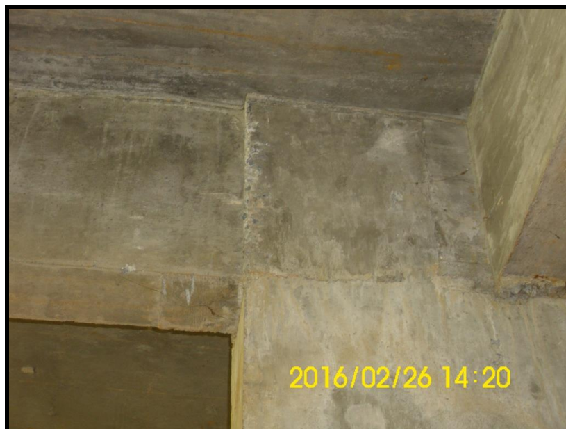
Foto 31 - 1º PAVIMENTO - Nicho de concretagem.
