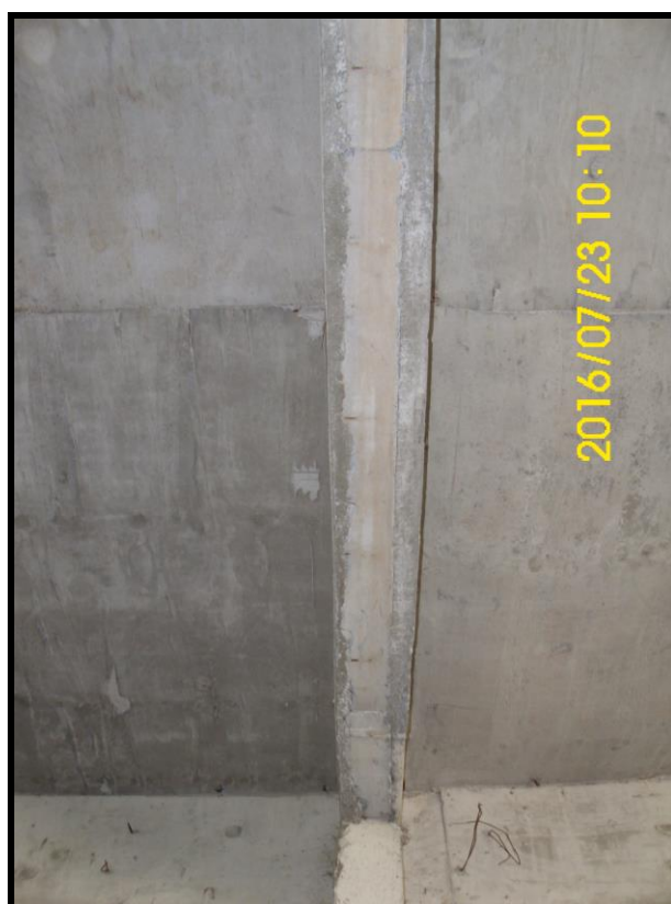
Foto 174 - 3º PAVIMENTO - Reparo em viga, bem como trinca em trecho médio.
