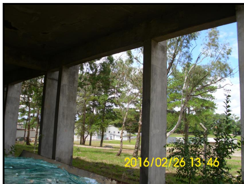
Foto 4 - TÉRREO/BALDRAMES - Aspecto geral da estrutura.
