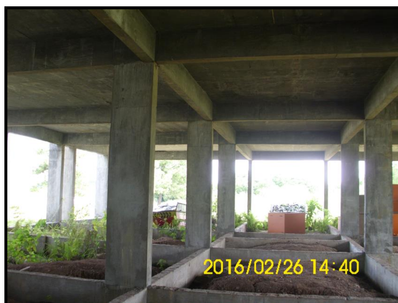
Foto 48 - TÉRREO/BALDRAMES - Aspecto geral da estrutura.
