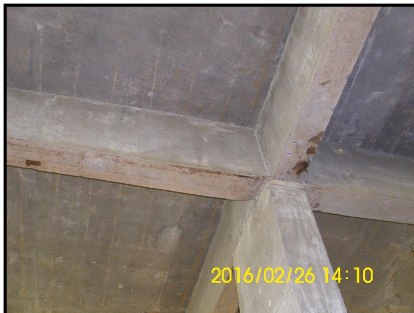
Foto 21 - 1º PAVIMENTO - Mapeamento de armaduras em viga.
