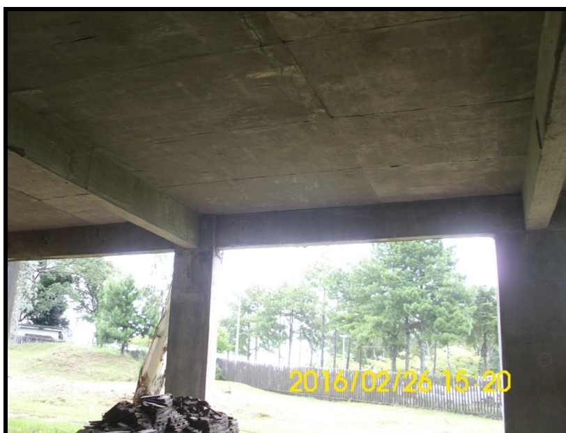
Foto 78 - 1º PAVIMENTO - Aspecto geral da laje.
