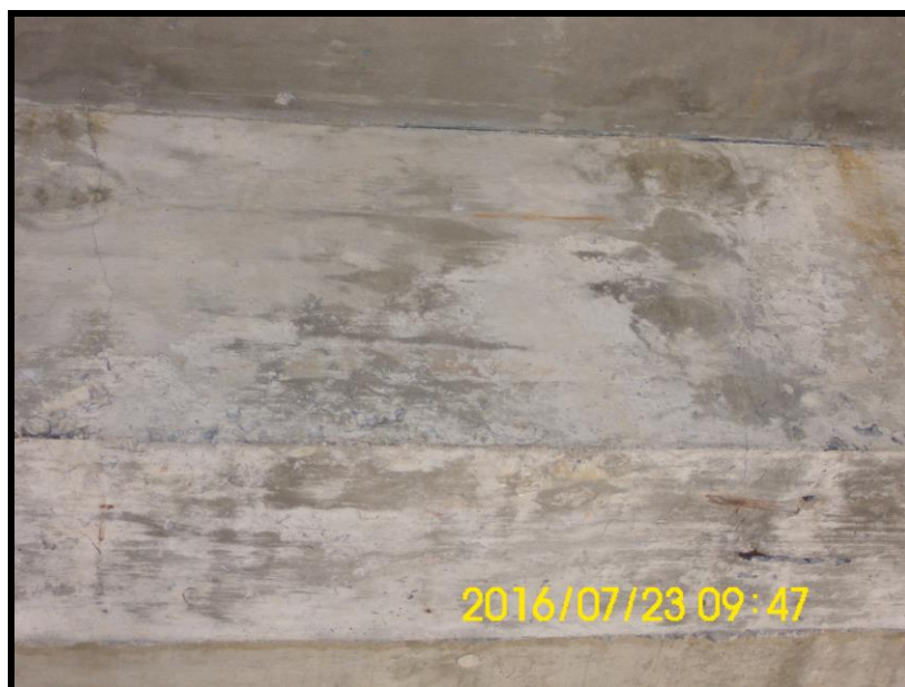
Foto 155 - 3º PAVIMENTO - Armadura exposta em reparo em viga.
