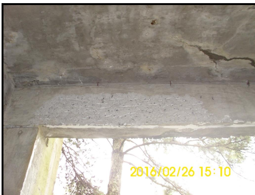
Foto 72 - 1º PAVIMENTO - Reparo em viga.
