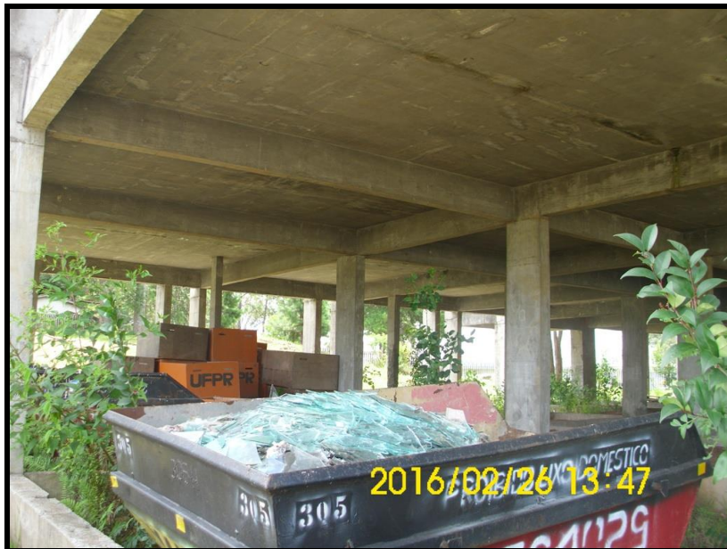
Foto 5 - TÉRREO/BALDRAMES - Aspecto geral da estrutura.
