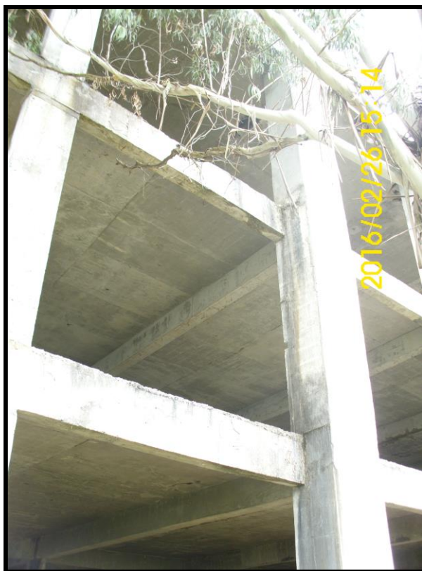
Foto 75 - Aspecto geral da estrutura.
