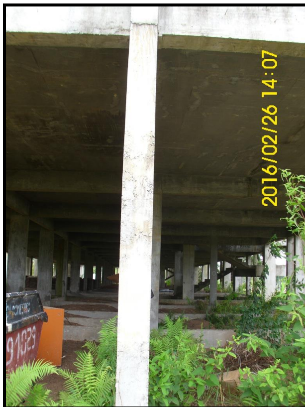
Foto 23 - TÉRREO/BALDRAMES - Pilar com nichos de concretagem.
