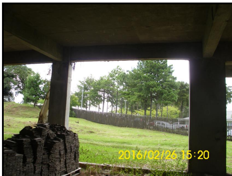
Foto 77 - TÉRREO/BALDRAMAS - Aspecto geral da laje.
