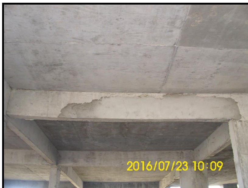
Foto 173 - 3º PAVIMENTO - Reparo em viga, bem como trinca em trecho médio.
