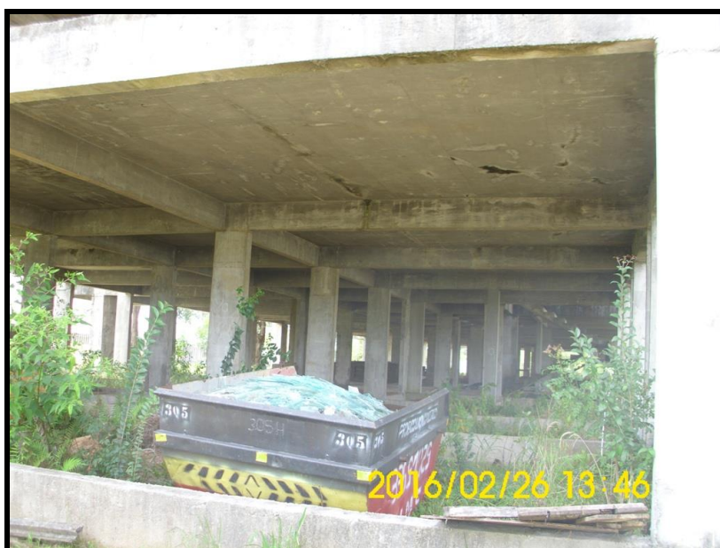
Foto 2 - TÉRREO/BALDRAMES - Aspecto geral da fachada lateral esquerda.
