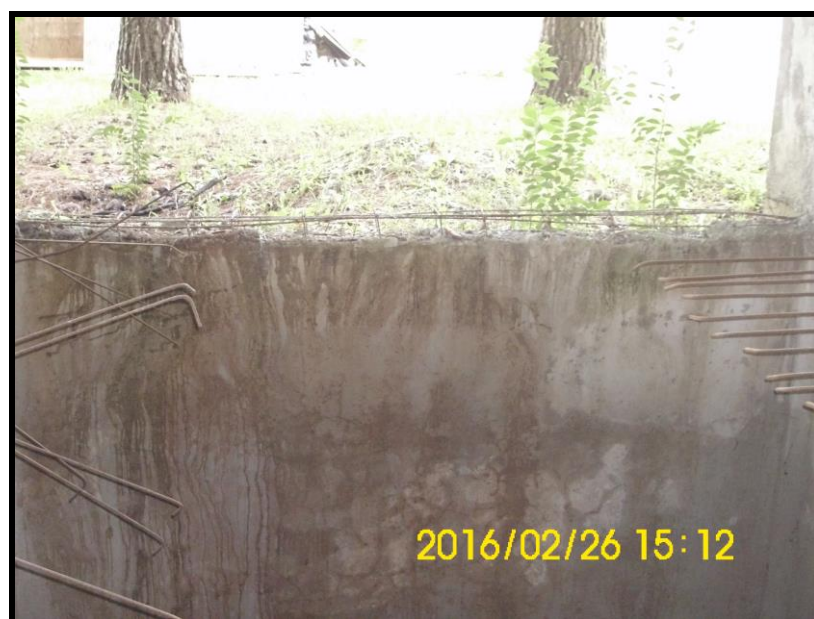
Foto 74 - TÉRREO/BALDRAMES - Estrutura da laje inacabada.
