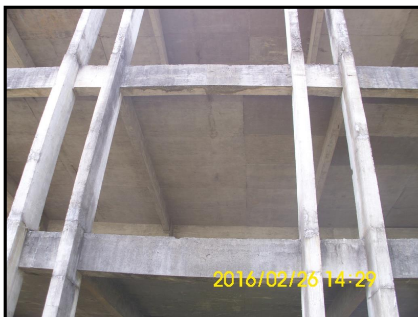
Foto 38 -1º PAVIMENTO - Aspecto geral da fachada frontal.
