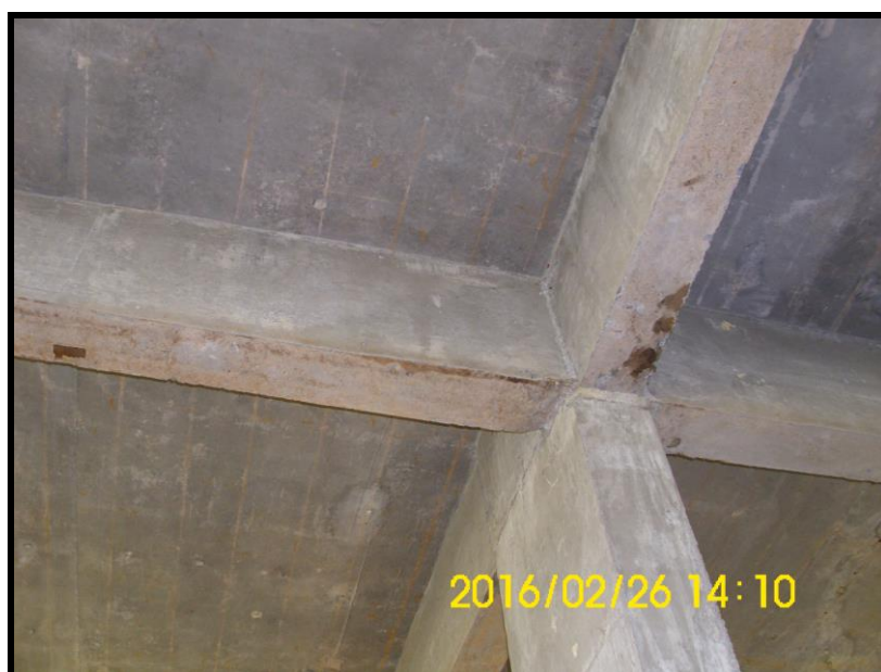
Foto 26 - 1º PAVIMENTO - Mapeamento de armaduras em viga.
