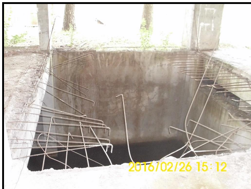
Foto 73 - TÉRREO/BALDRAMES - Estrutura da laje inacabada.
