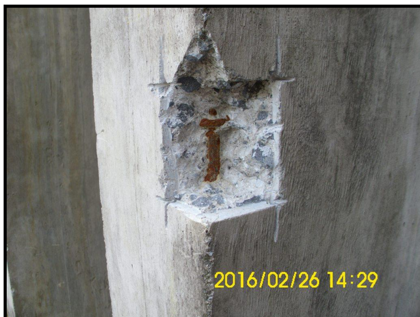
Foto 37 - 1º PAVIMENTO - Testemunho retirado de trecho de pilar.
