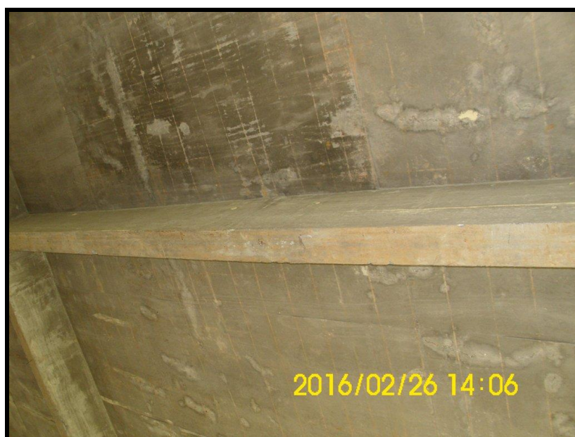
Foto 22 - 1º PAVIMENTO - Mapeamento de armaduras em lajes e vigas.
