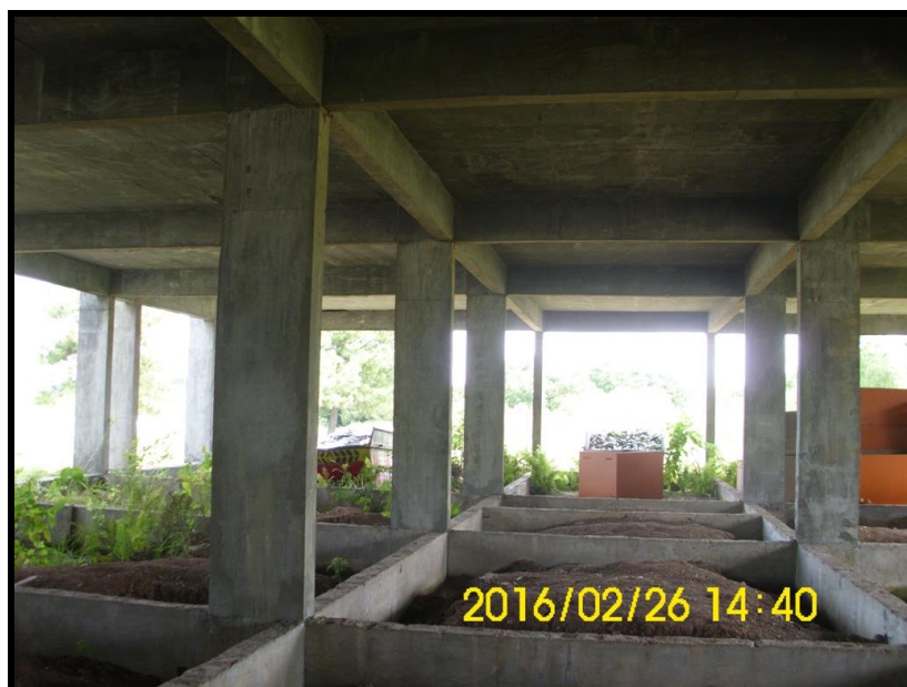
Foto 49 - TÉRREO/BALDRAMES - Aspecto geral da estrutura.
