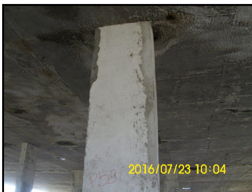
Foto 170 - 2º PAVIMENTO - Reparos em pilares.
