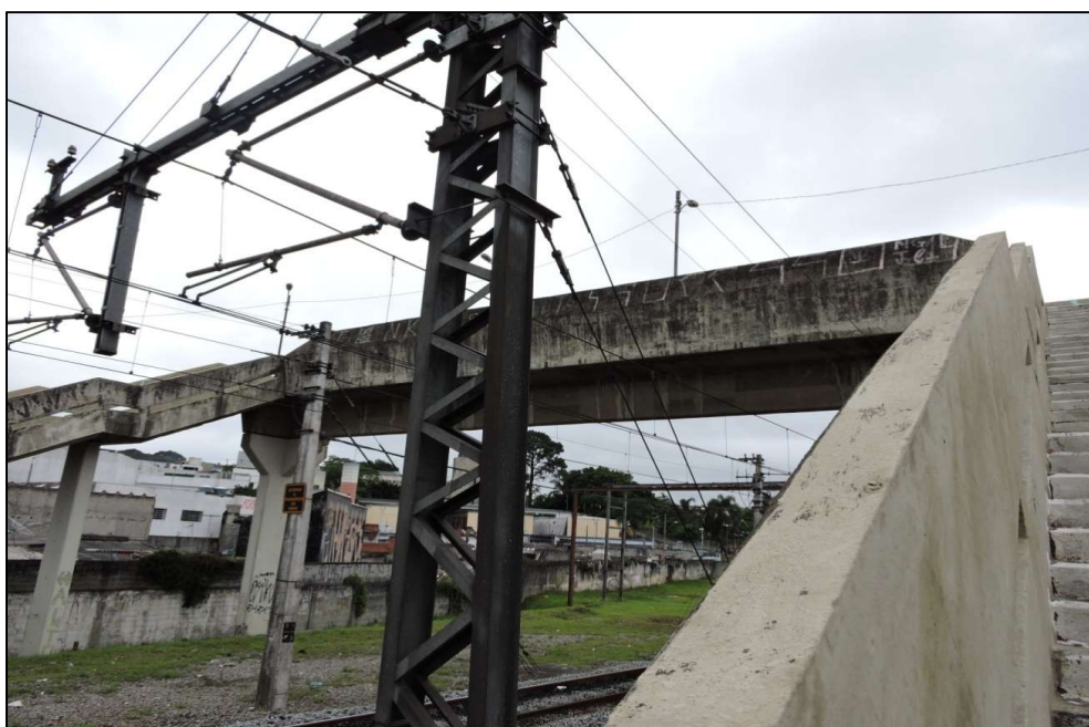
Fotografia 9. Vista geral da passarela 3.
