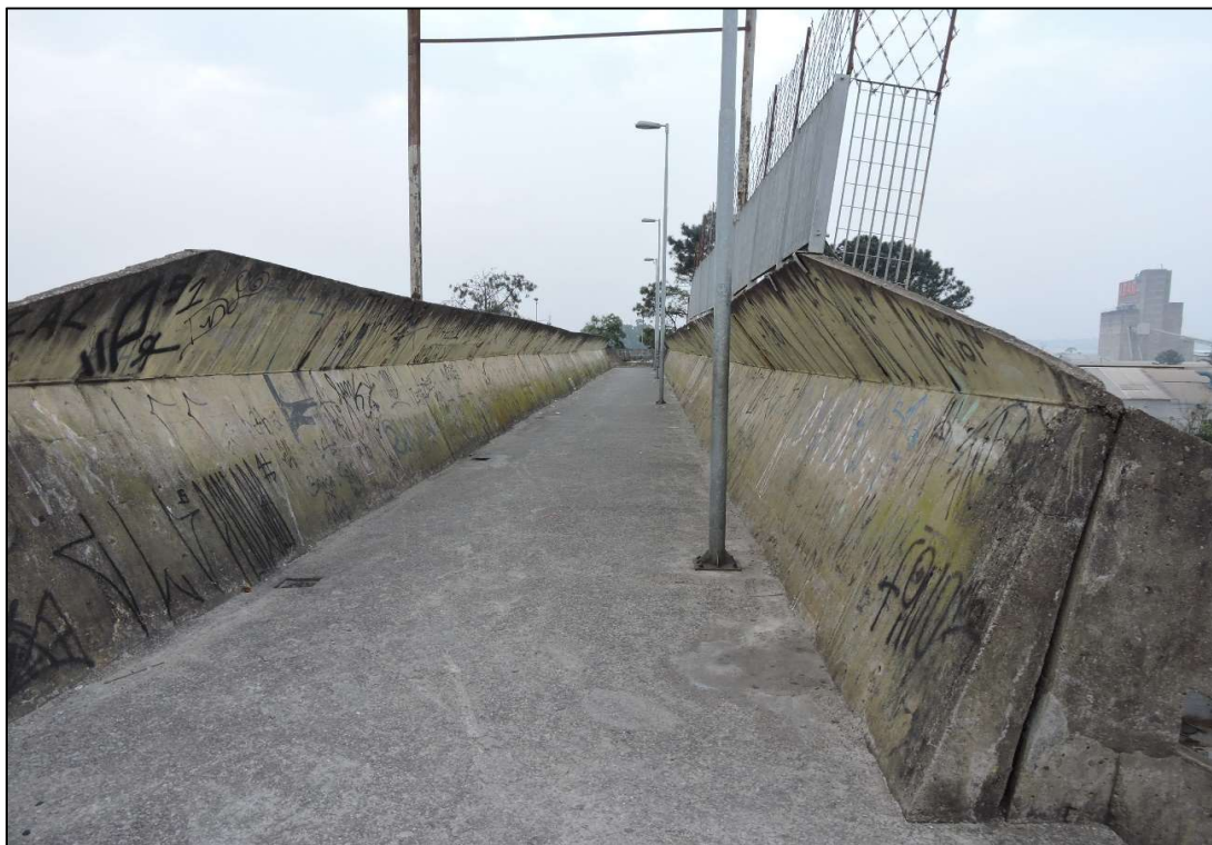
Fotografia 3. Vista geral do tabuleiro da passarela.
