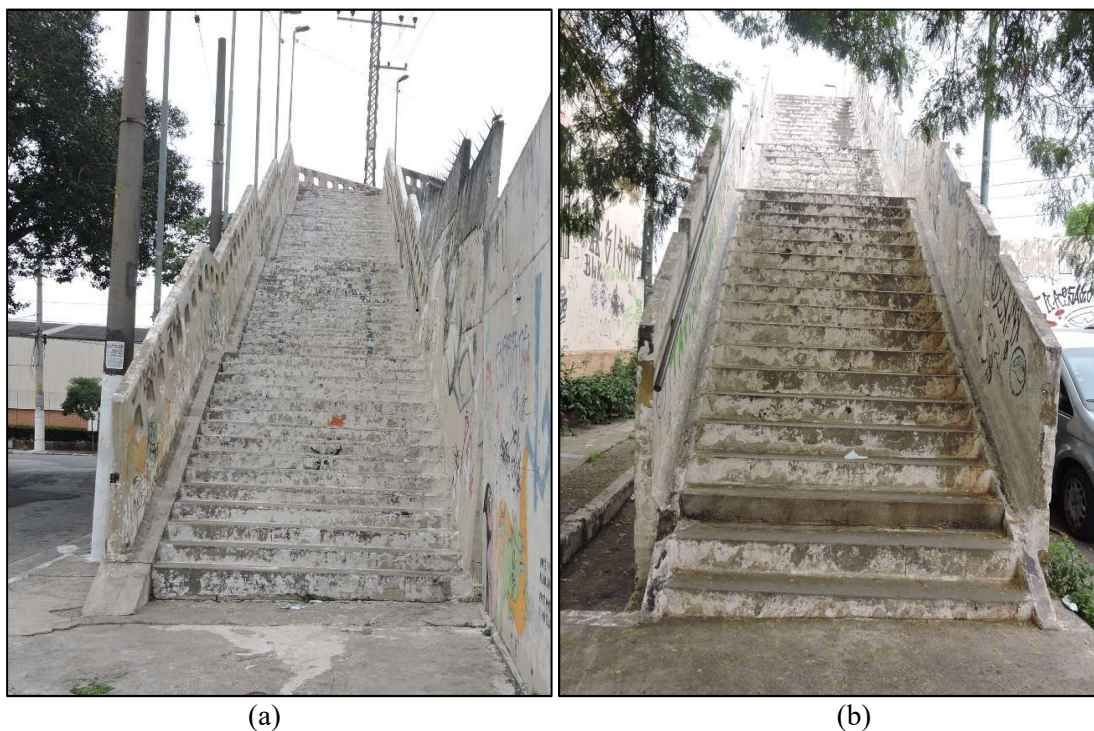
Fotografia 26. Escadas de acesso (a) escada de acesso pela Rua Willian Speers; (b) escada de acesso pela Rua do Curtume.
