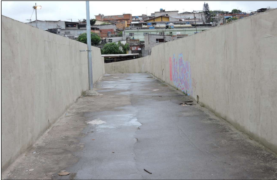
Fotografia 7. Vista geral do tabuleiro da passarela.
