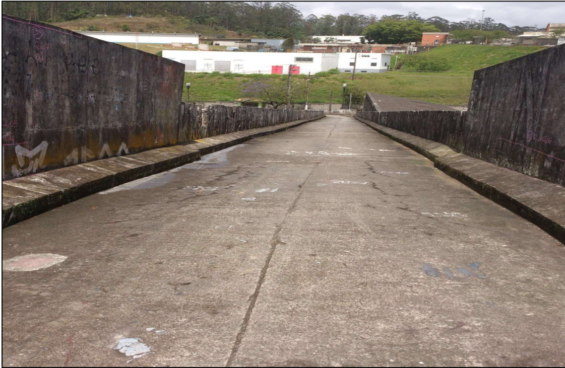
Fotografia 19. Vista geral do tabuleiro da passarela Vila Gomes.
