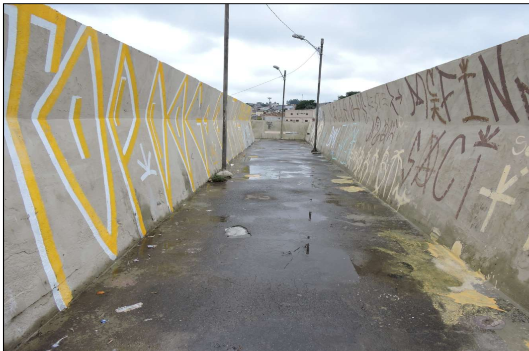
Fotografia 11. Vista geral do tabuleiro da passarela.
