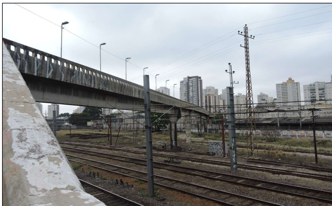
Fotografia 25. Vista geral da passarela 7.
