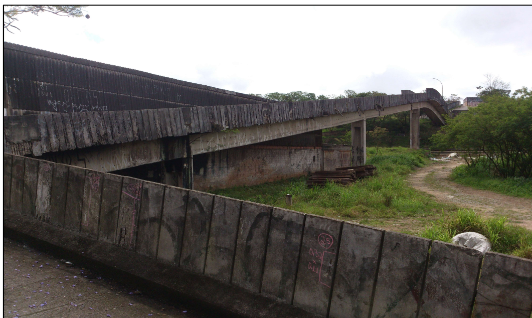
Fotografia 17. Vista geral da passarela 5.
