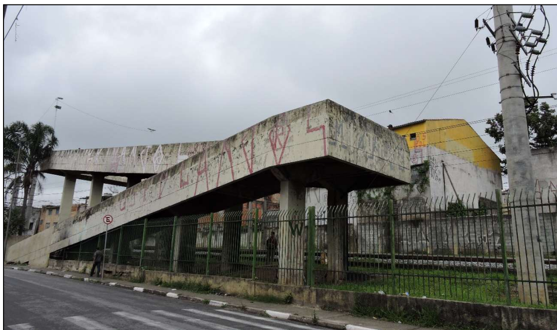
Fotografia 5. Vista geral da passarela 2.
