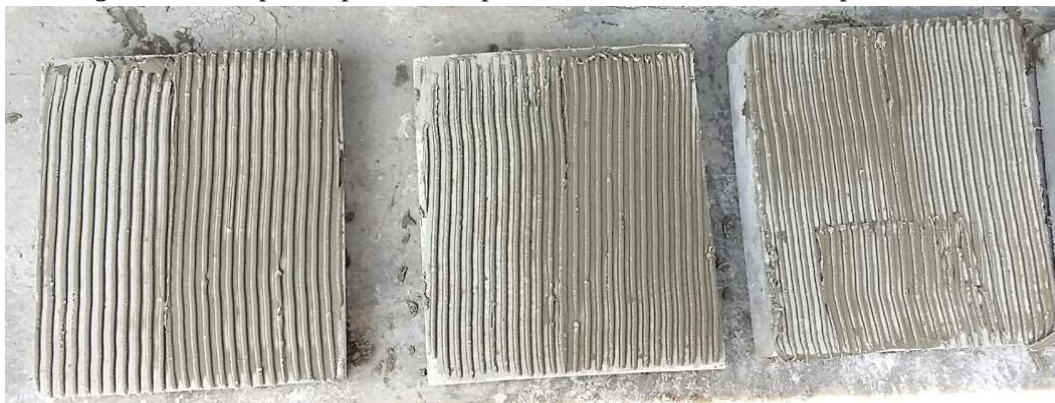
Figura 22 – Chapisco aplicado nas placas de 50, 40 e 60 MPa, respectivamente.
