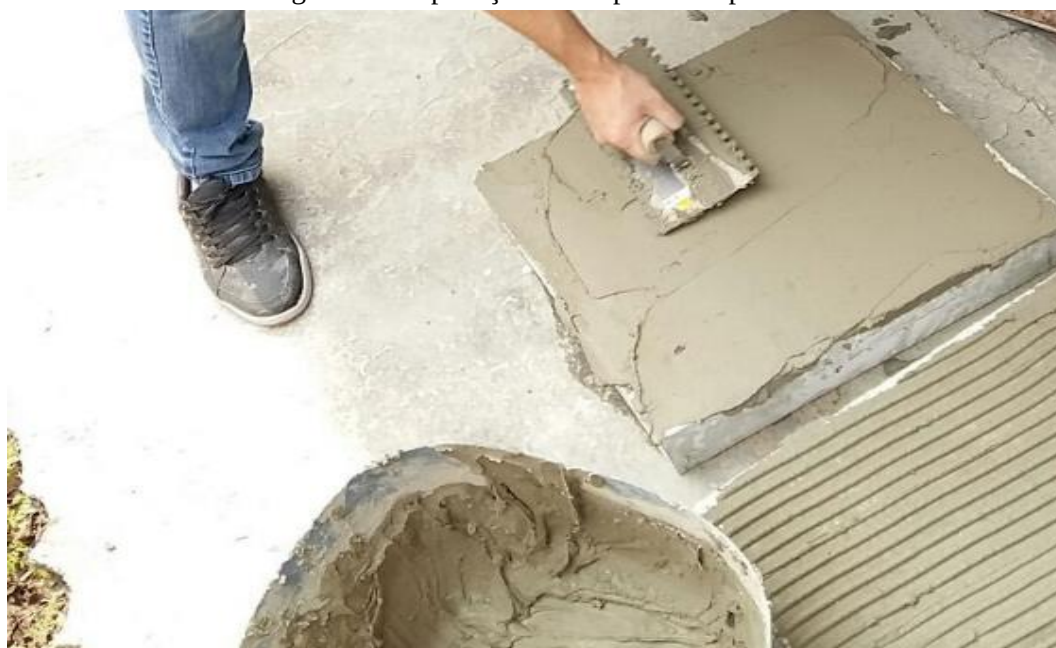
Figura 21 – Aplicação do chapisco nas placas.
