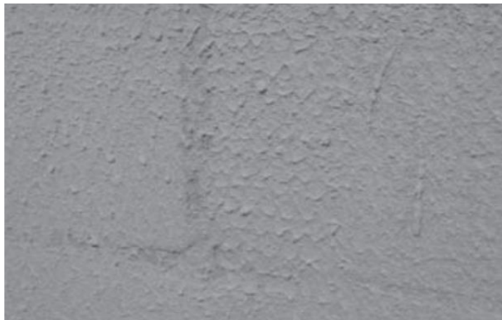
Figura 5 – Aspecto da superfície do chapisco rolado.
