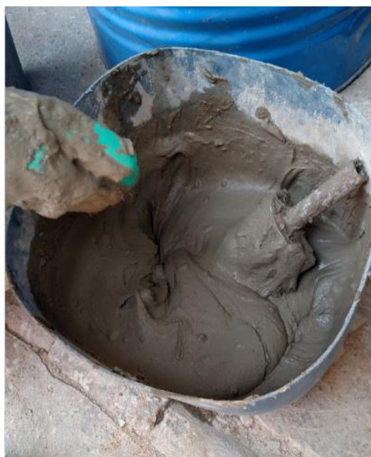
Figura 20 – Mistura do chapisco colante.
