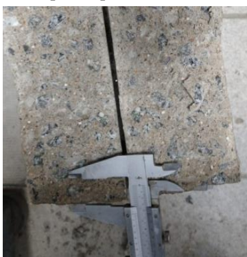
Medição da profundidade de penetração no ensaio de absorção - visual
