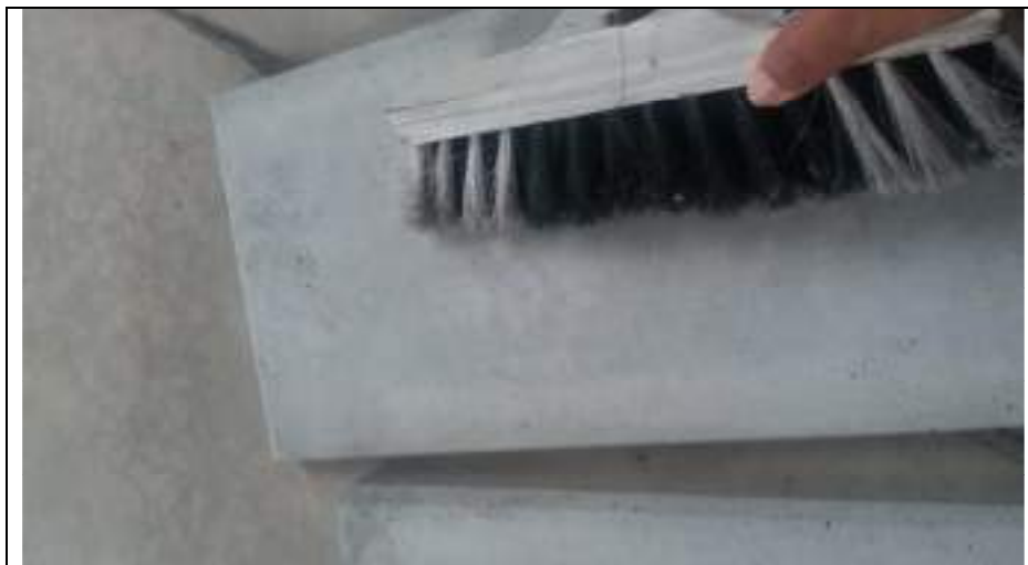
Figura 11. Preparação das bases de revestimento – Placas GRUPO B remoção do pó (AUTORES)
