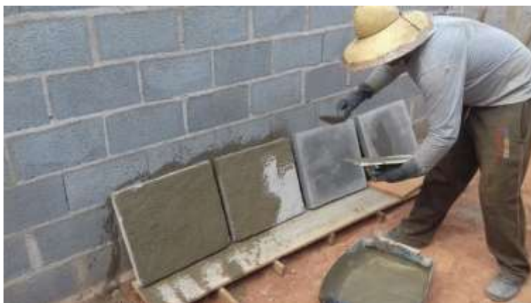
Figura 15 – Execução do Chapisco.
