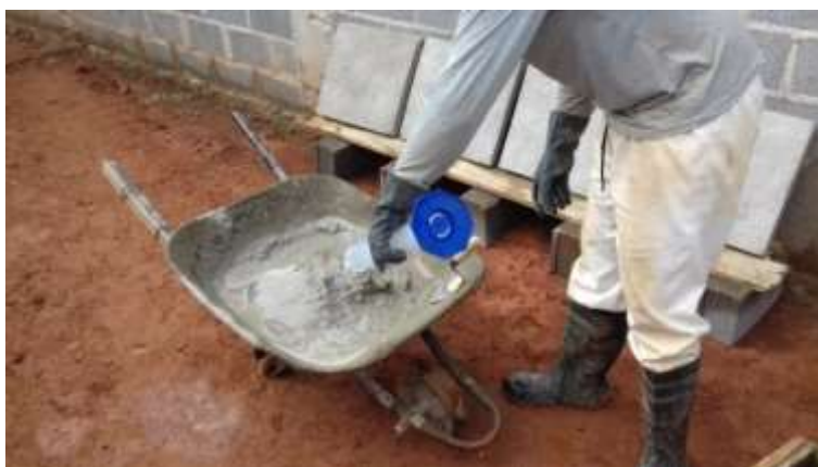
Figura 17 - Dosagem de água / Execução da massa.
