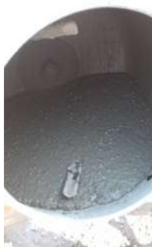
Figura 10 – Mistura do concreto em betoneira.
