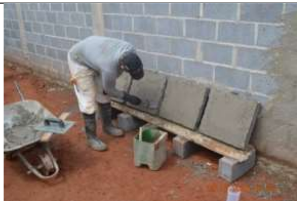
Figura 18 – Execução do revestimento.
