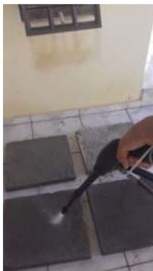
Figura 14 – Tratamento de limpeza com jato de água com alta pressão.
