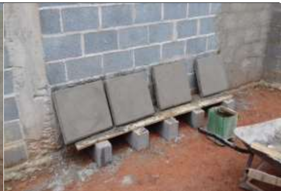
Figura 19 – Placas revestidas com argamassa.
