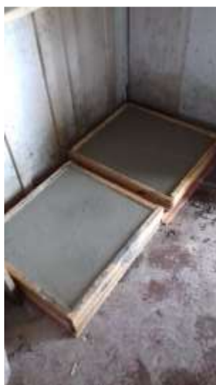
Figura 12 – Moldagem das placas de concreto.
