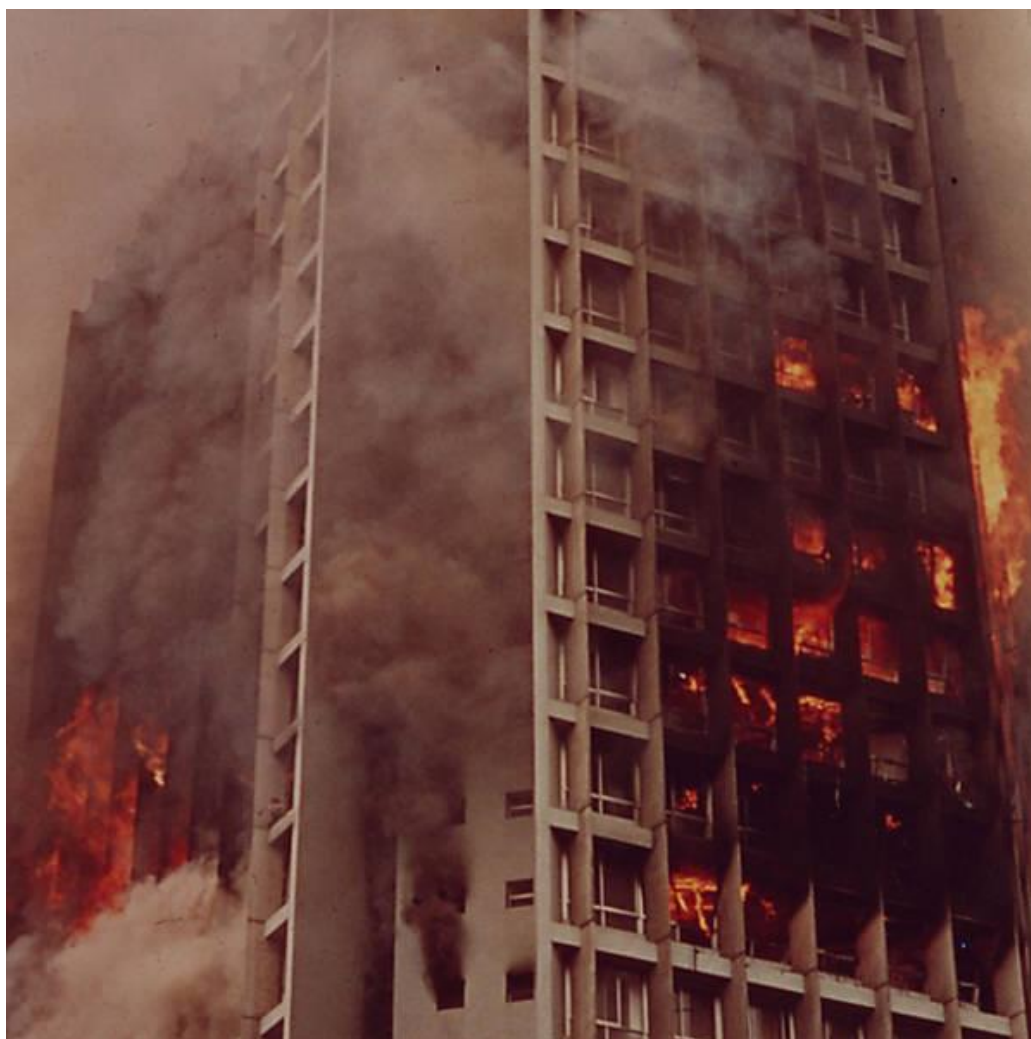
Figura 7 - Incêndio Edifício Joelma-1974, SP (Fonte: Eivind Molberg-1º.fev.1974/Folhapress)
