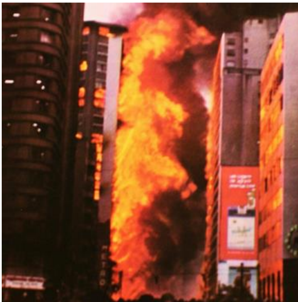
Figura 6 - Incêndio Edifício Andraus -1972, SP (Fonte: Pinterest)
