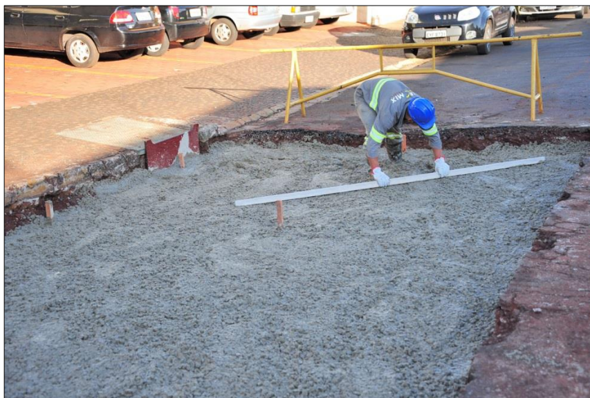
Figura 28. Sub-base de concreto (ROMERO, 2016).
