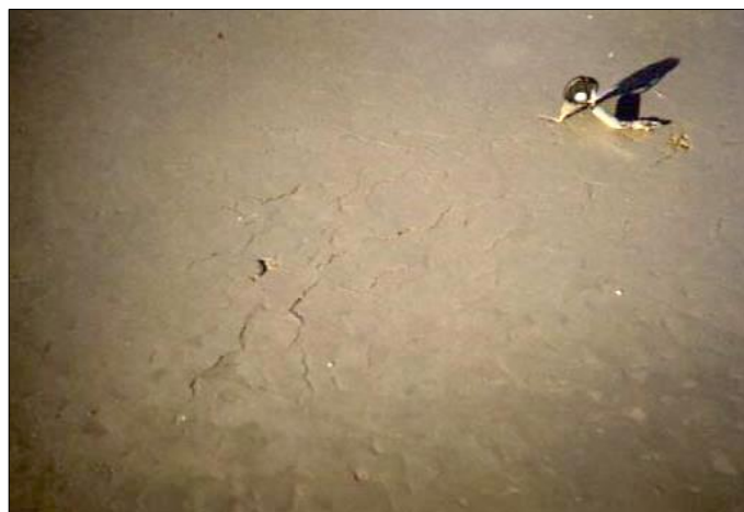
Figura 15. Ocorrência de borrachudo em piso de concreto (CHODOUNSKY, 2010).
