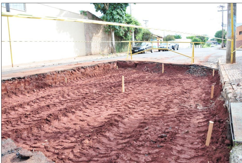
Figura 27. Preparação de subleito (ROMERO, 2016).
