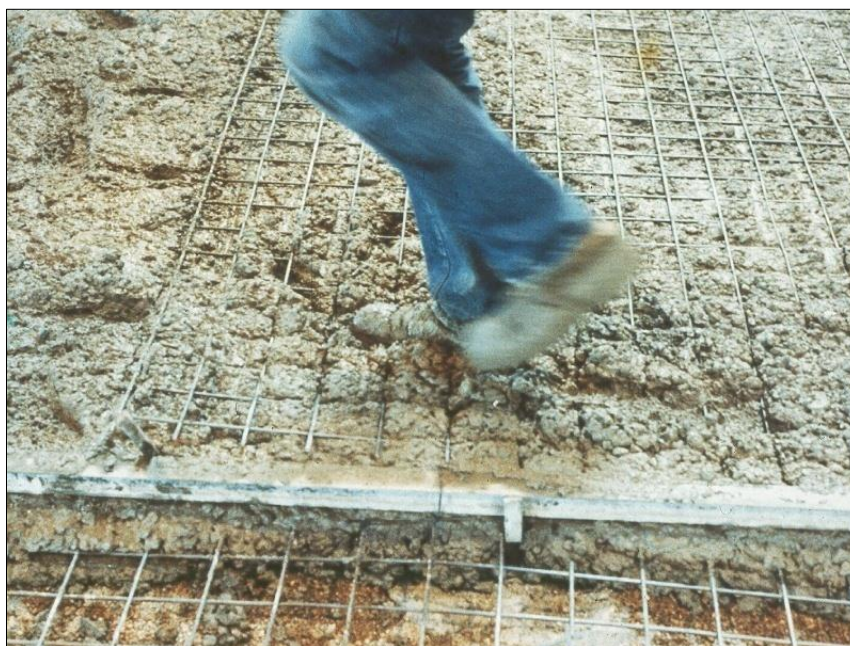
Figura 29. Trânsito de operário sobre a armadura (GRANATO, 2014).
