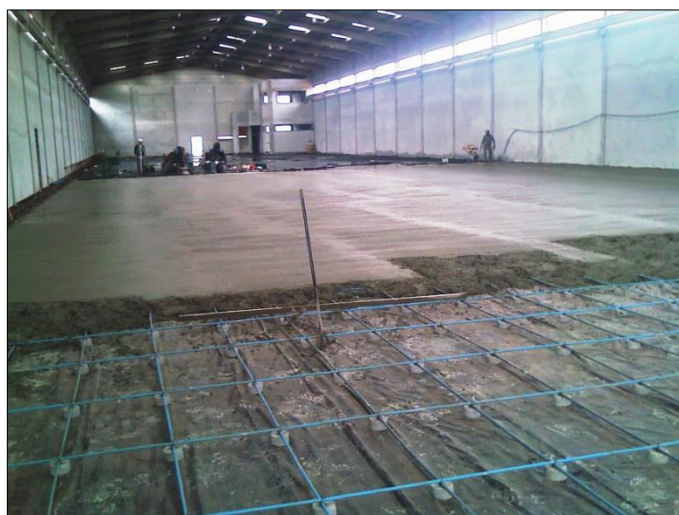
Figura 8. Piso de concreto protendido (AEAJS, 2017).
