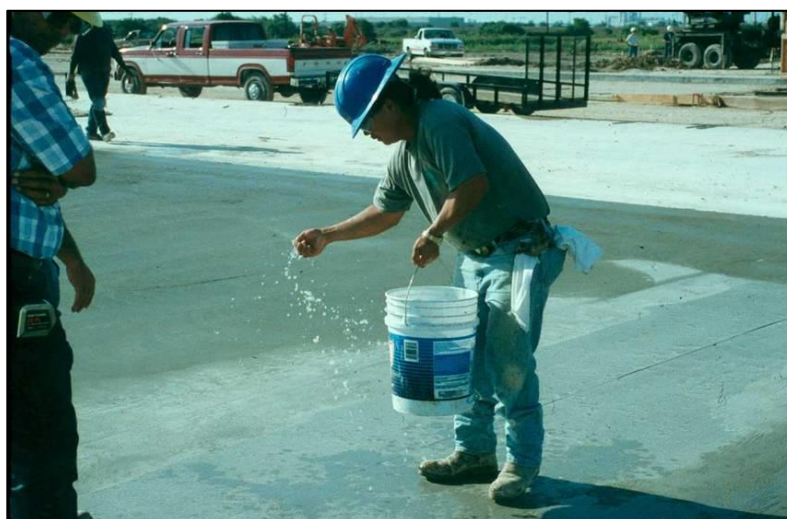
Figura 23. Excesso de água na superfície durante acabamento (GRANATO, 2014).
