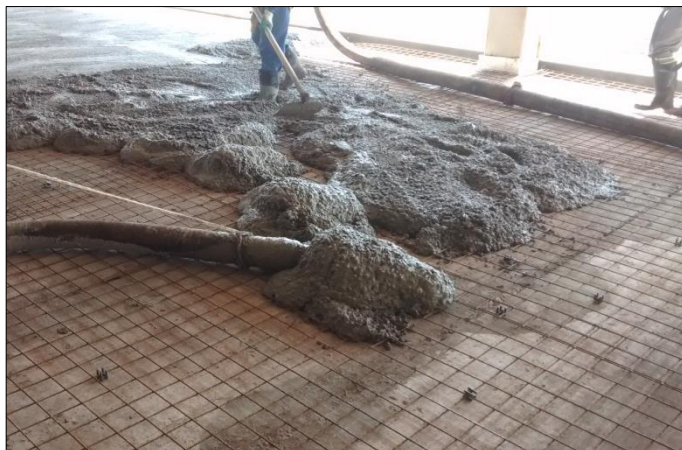
Figura 5. Piso de concreto armado (ROMERO, 2016).
