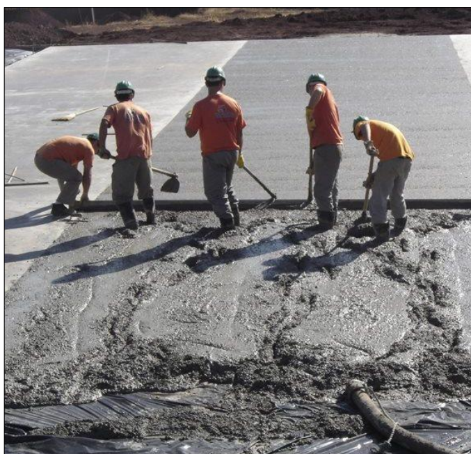
Figura 4. Piso de concreto sem armadura (TECNIKA, 2017).
