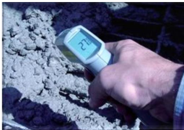
Figura 25. Medida da temperatura do concreto a laser (SILVA E BATTAGIN, 2011).
