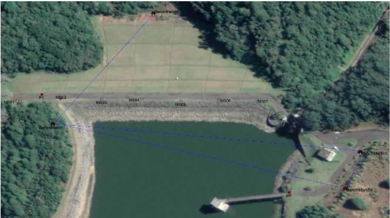
Figura 28 - Pontos de referência benchmark de uma barragem de terra de uma usina hidrelétrica pertencente a empresa do setor elétrico brasileiro - Fonte: Google Earth 03/06/2021
