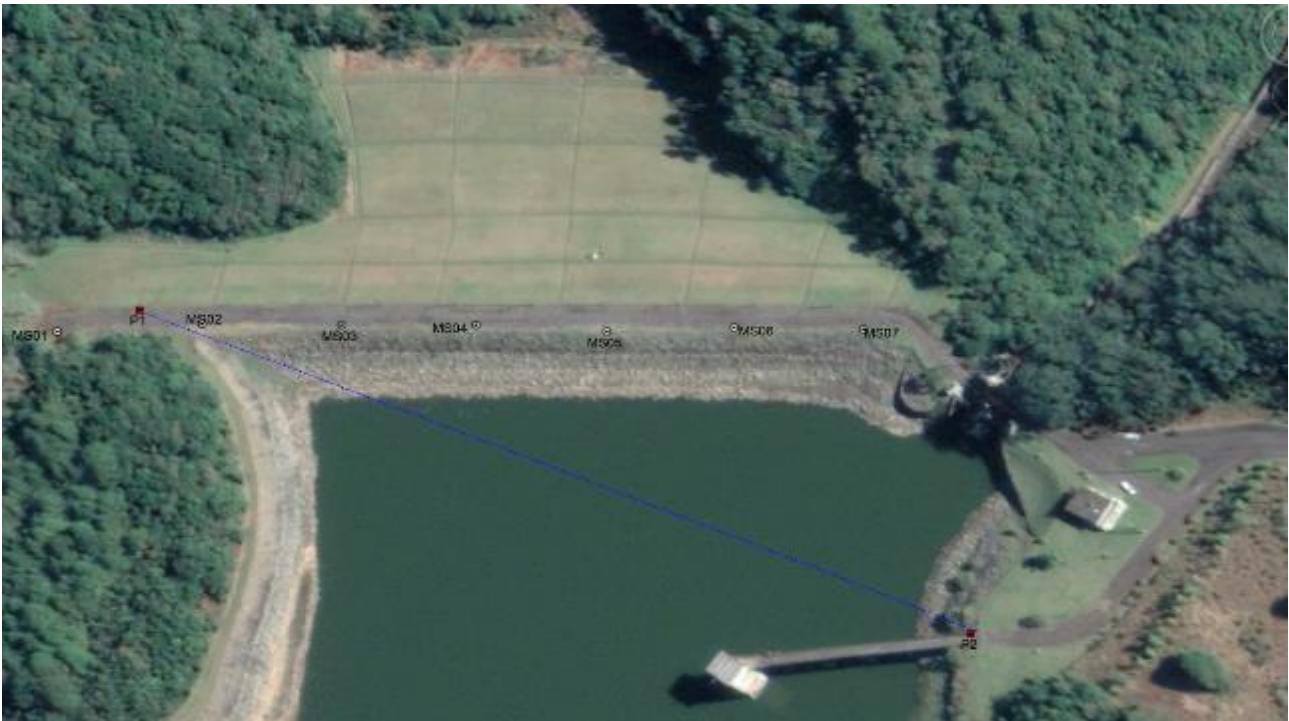
Figura 26 - Pontos de referência de uma barragem de terra de uma usina hidrelétrica pertencente a uma empresa do setor elétrico brasileiro - Fonte: Google Earth 03/06/2021
