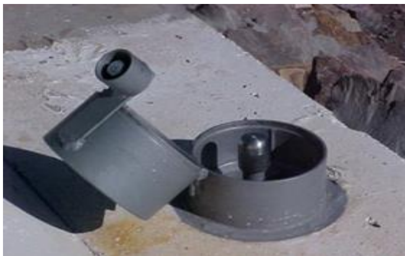
Figura 20 - MSCf - Marco Superficial para instalação em Concreto fresco (ancoragem no concreto - Tipo rabo de andorinha). Fonte (COMMETRO, 2021).
