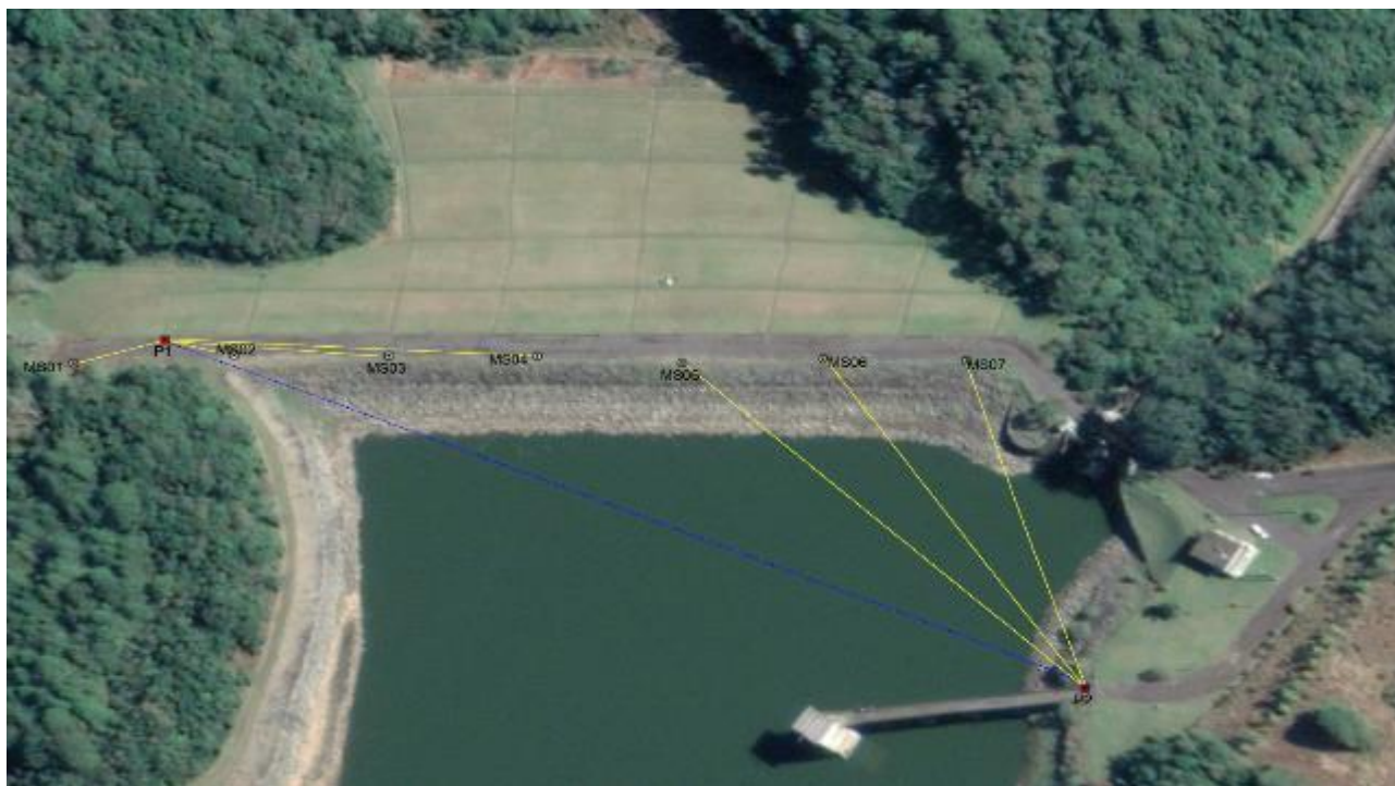
Figura 27 - Irradiação de marcos superficiais barragem de terra de uma usina hidrelétrica pertencente a uma empresa do setor elétrico brasileiro - Fonte: Google Earth 03/06/2021
