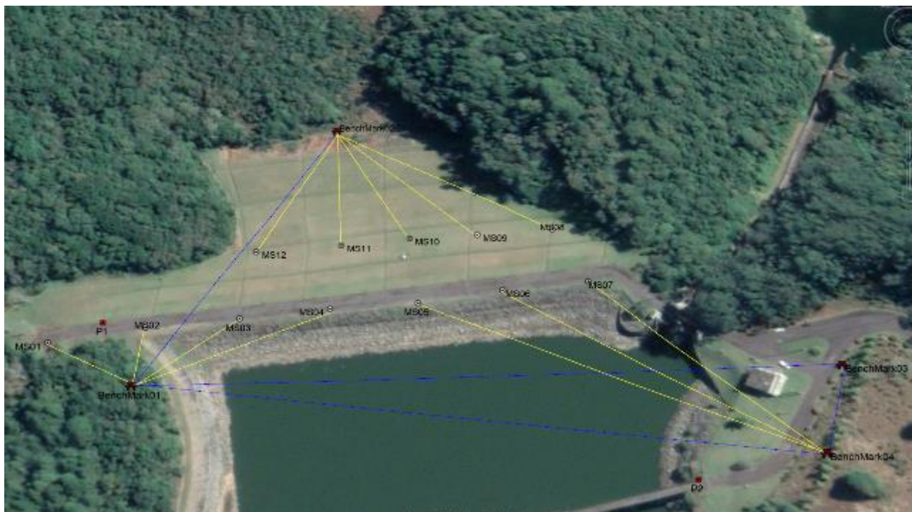
Figura 29 - Irradiação dos marcos superficiais através dos pontos de referência benchmark de uma barragem de terra de uma usina hidrelétrica pertencente a empresa do setor elétrico brasileiro - Fonte: Google Earth 03/06/2021
