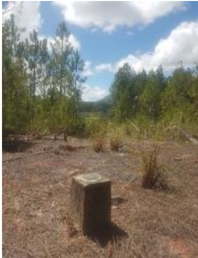
Figura 6 - Marco pré-moldado de concreto - Fonte: próprio autor
