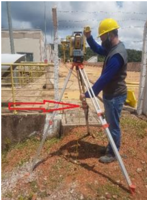
Figura 22 - Obtenção de medida para definição da altura do instrumento com a utilização de trena - Fonte: próprio autor
