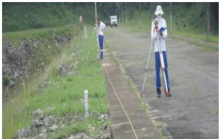
Figura 17 - Marco instalado em calçada sobre a barragem.
