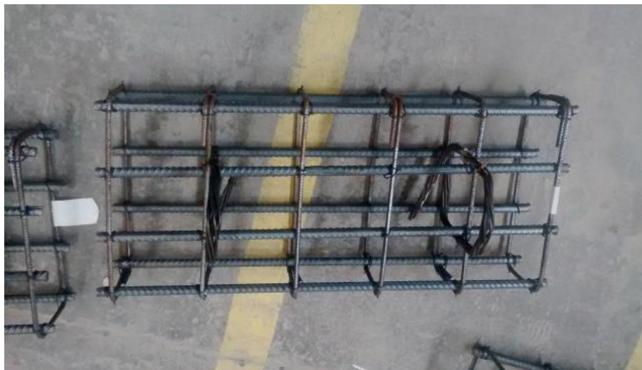
Figura 14-b. Confecção da armadura para pilar e consolos distintos. Fonte: o autor, 2016.
