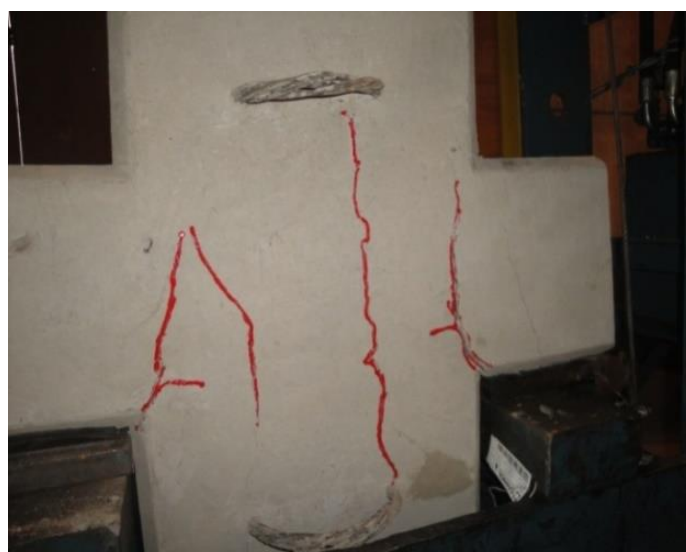
Figura 20-b. Panorama de fissuração do modelo M03-C8.
