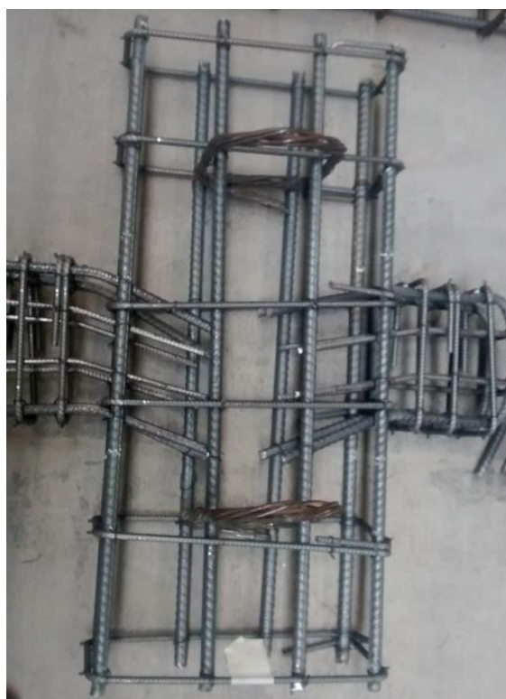
Figura 15. Confecção de armadura para pilar e consolos monolíticos (ancoragem parcial). Fonte: o autor, 2016.
