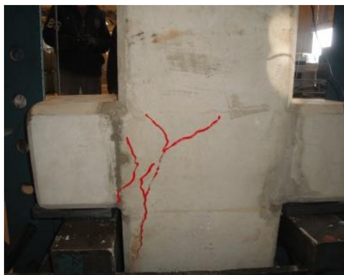
Figura 18-b. Panorama de fissuração do modelo M01-C2.
