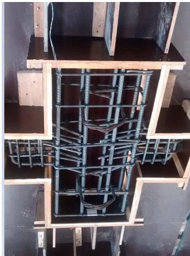
Figura 16. Forma e armadura para pilar e consolos monolíticos (ancoragem parcial). Fonte: o autor, 2016.
