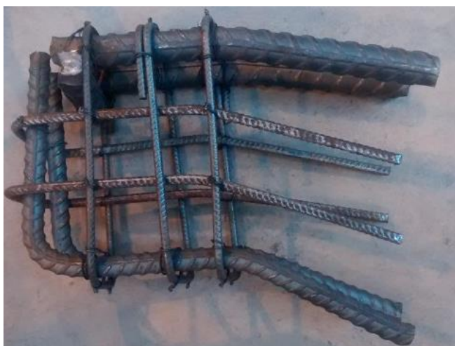
Figura 14-a. Confecção da armadura para pilar e consolos distintos. Fonte: o autor, 2016.
