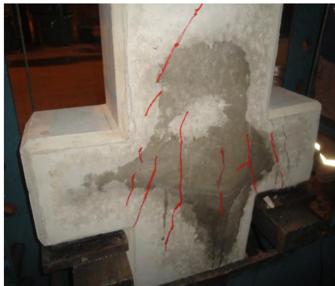
Figura 21-c. Panorama de fissuração do modelo M04-C12. Fonte: o autor, 2016.
