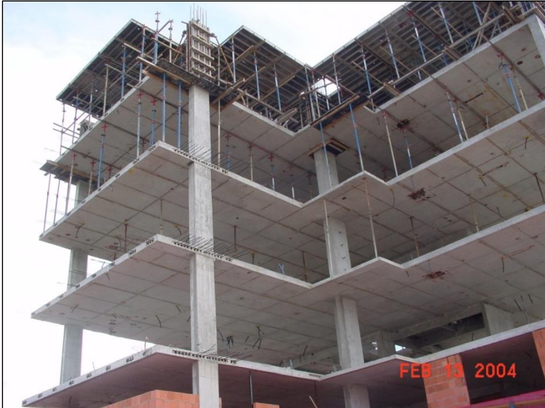
Figura 10: Edificação com laje lisa protendida maciça sem vigas de borda. Fonte: ProCalc Estruturas, 2004. Arquivo.
