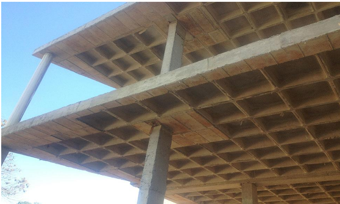
Figura 11: Laje Lisa Nervurada Fonte: ProCalc Estruturas, 2006. Arquivo.
