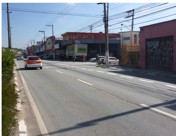
Foto 5 - Trincas isoladas e trinca proveniente de junta de construção na divisão de faixas - próximo à estação Comandante Sampaio
