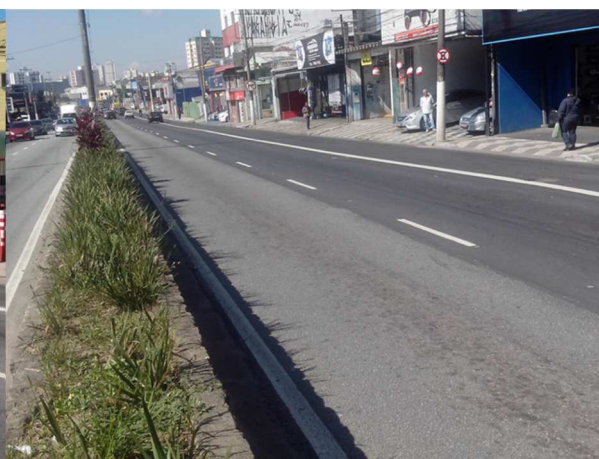
Foto 4 - Pavimento em bom estado e recapeamento recente nas 2 faixas da direita - próximo à estaca 1.065+0,00
