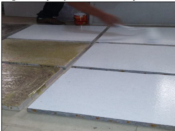
Figura 11: Aplicação de latex sobre as placas de concreto
