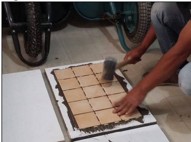
Figura 22: Assentamento do revestimento cerâmico
