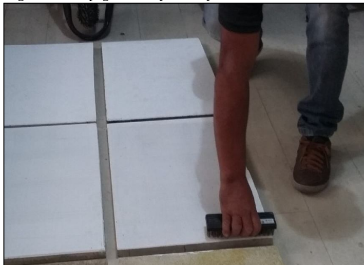
Figura 14: Raspagem da superfície pintada
