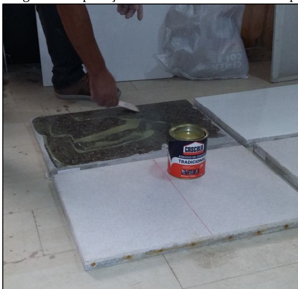
Figura 12: Aplicação de cola de contato sobre as placas de concreto
