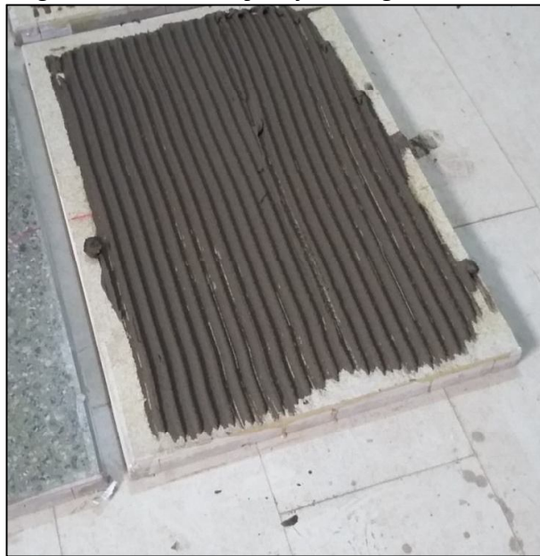
Figura 21: Sentido da aplicação da argamassa
