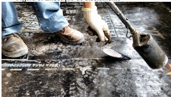
Figura 8: Execução de biselamento
