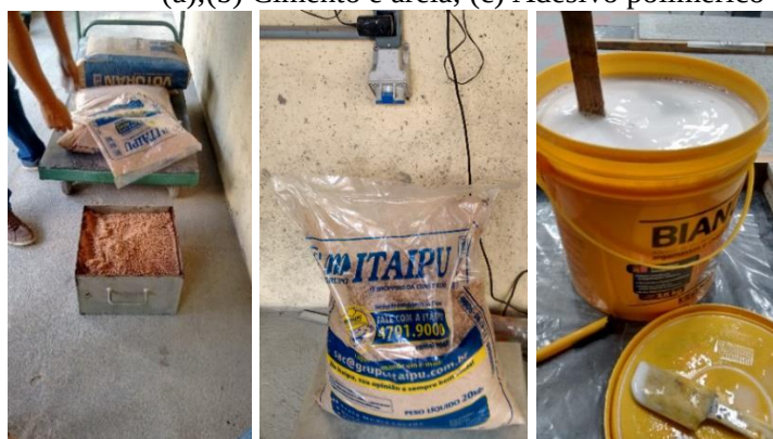
Figura 24 Materiais argamassa regularização: (a);(b) Cimento e areia; (c) Adesivo polimérico
