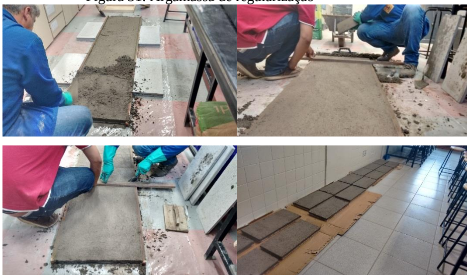
Figura 31: Argamassa de regularização
