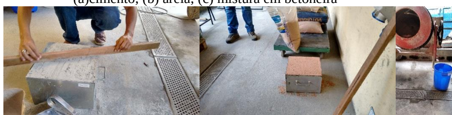
Figura 29 Dosagem argamassa: (a)cimento; (b) areia; (c) mistura em betoneira
