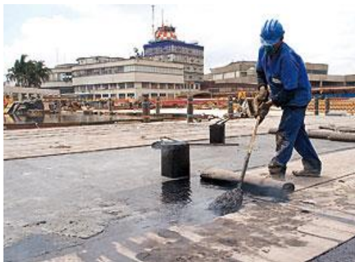
Figura 6: Aplicação de manta asfáltica com asfalto à quente
