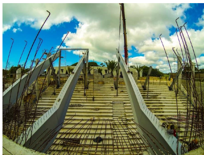
Figura 20: Vista do encontro de vigas metálicas com estruturas em concreto armado – Fonte: Arquivos de obra do Teatro L Occitane.
