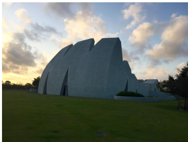
Figura 24: Vista da fachada principal (Anfiteatro) com etapa de aplicação de hidrofugante elástico – Fonte: Arquivos de obra do Teatro L Occitane.
