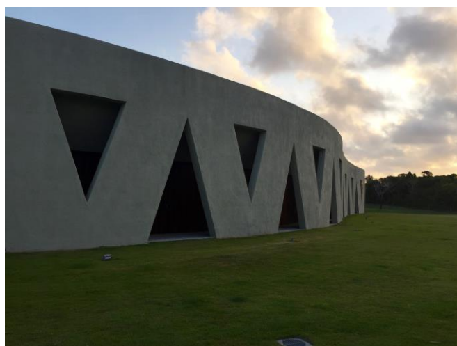
Figura 25: Vista da fachada principal (Facilities) com etapa de aplicação de hidrofugante elástico – Fonte: Arquivos de obra do Teatro L Occitane.
