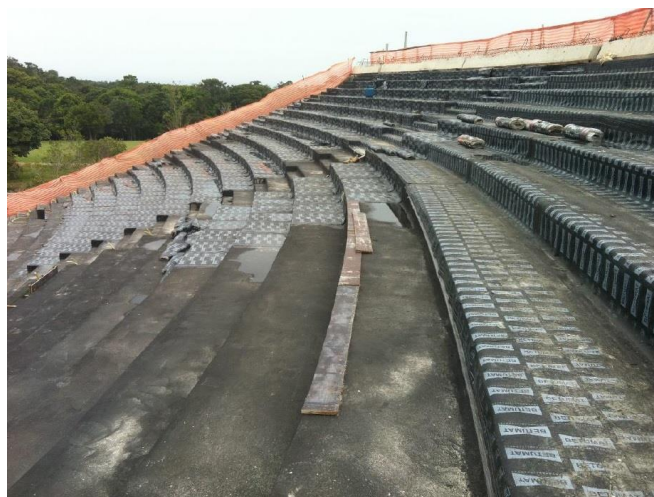
Figura 18: Vista da plateia A com impermeabilização de manta asfáltica – Fonte: Arquivos de obra do Teatro L Occitane.
