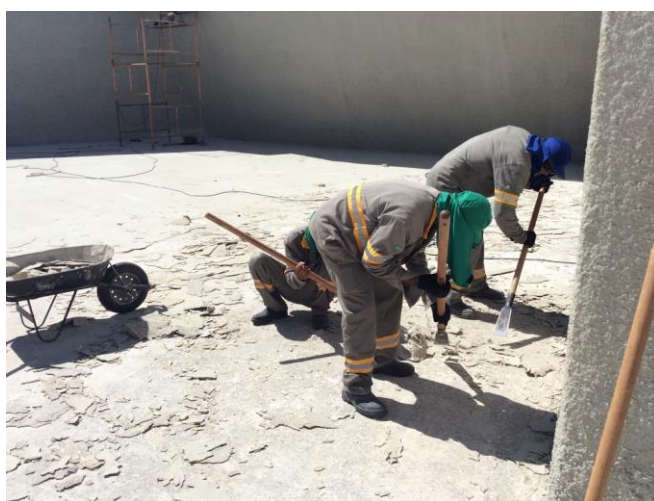
Figura 26: Vista do palco A na etapa de remoção de impermeabilização existente – Fonte: Arquivos de obra do Teatro L Occitane.
