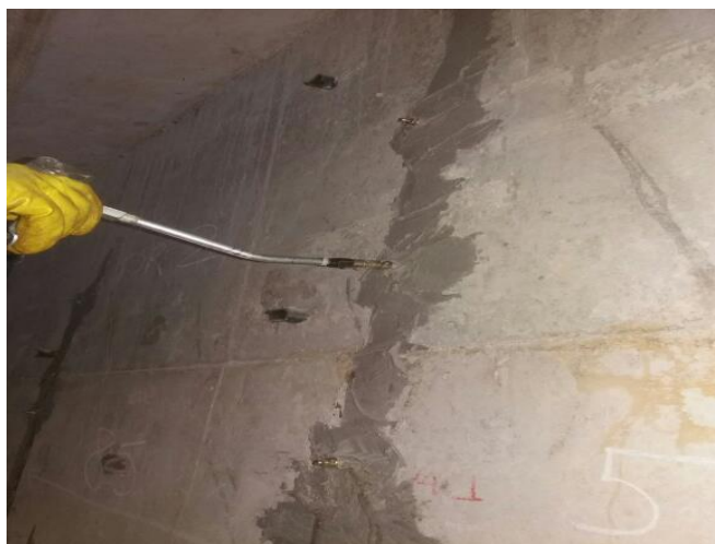
Figura 35: Vista da viga em concreto com injeção de epóxi – Fonte: Arquivos de obra do Teatro L Occitane.
