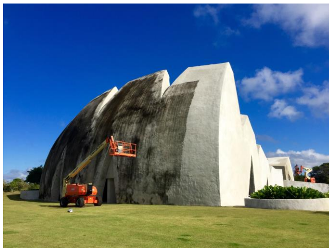
Figura 23: Vista da fachada principal (Anfiteatro) com etapa de hidrojateamento iniciada – Fonte: Arquivos de obra do Teatro L Occitane.
