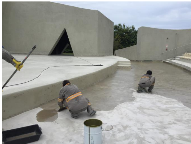
Figura 31: Vista da área de circulação com aplicação de primer de aderência ao sistema – Fonte: Arquivos de obra do Teatro L Occitane.
