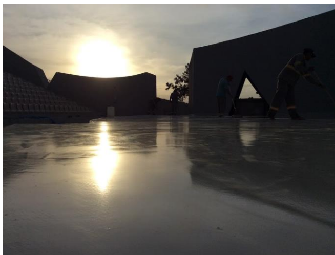
Figura 33: Vista da área do palco A com aplicação de camada impermeabilizante final – Fonte: Arquivos de obra do Teatro L Occitane.
