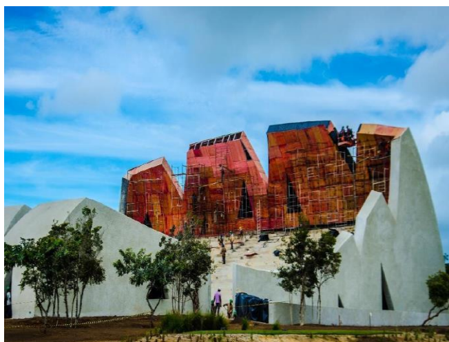
Figura 17: Vista das formas de madeira na fachada interna e plateia A – Fonte: Arquivos de obra do Teatro L Occitane.
