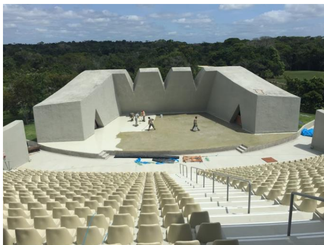
Figura 32: Vista da área do palco A com aplicação de camada impermeabilizante – Fonte: Arquivos de obra do Teatro L Occitane.
