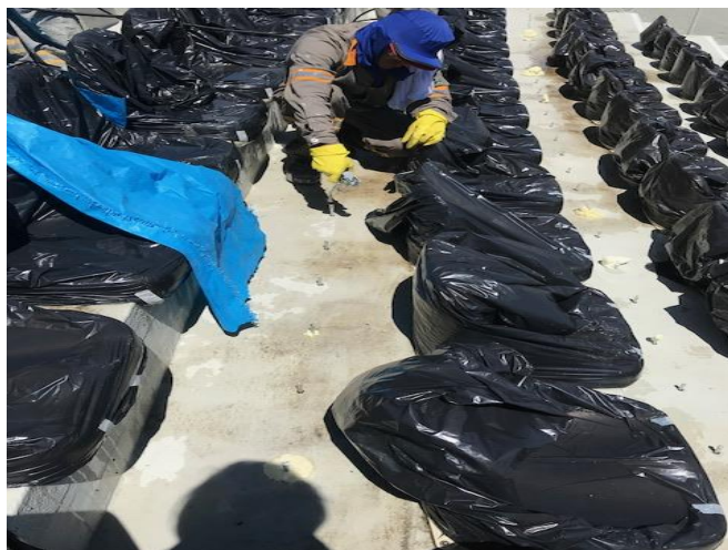
Figura 38: Vista da arquibancada com injeção de poliuretano em bicos — Fonte: Arquivos de obra do Teatro L Occitane.
