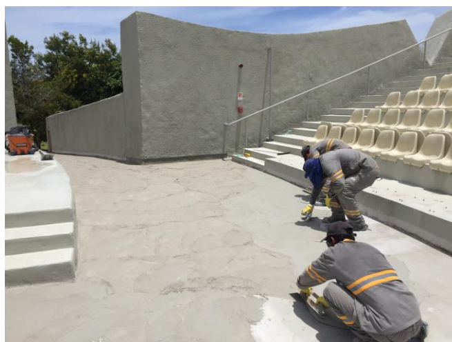
Figura 29: Vista da área de circulação com aplicação de barreira temporária ao vapor – Fonte: Arquivos de obra do Teatro L Occitane.
