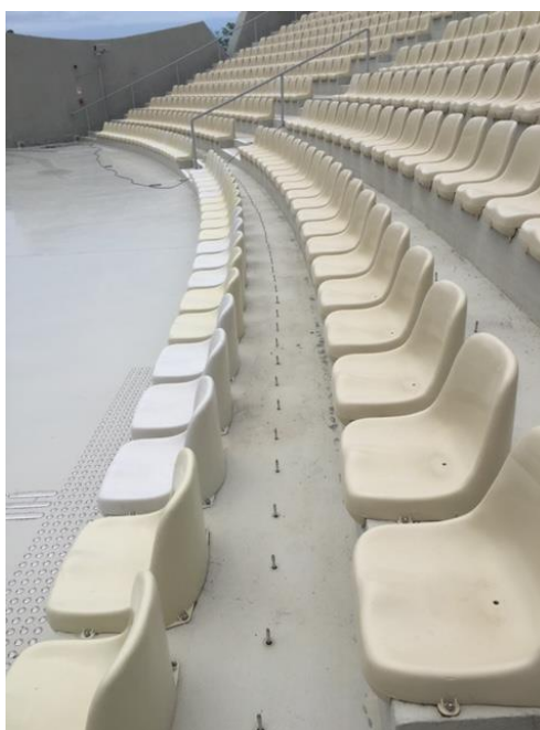
Figura 39: Vista da arquibancada com posicionamento de bicos injetores — Fonte: Arquivos de obra do Teatro L Occitane.
