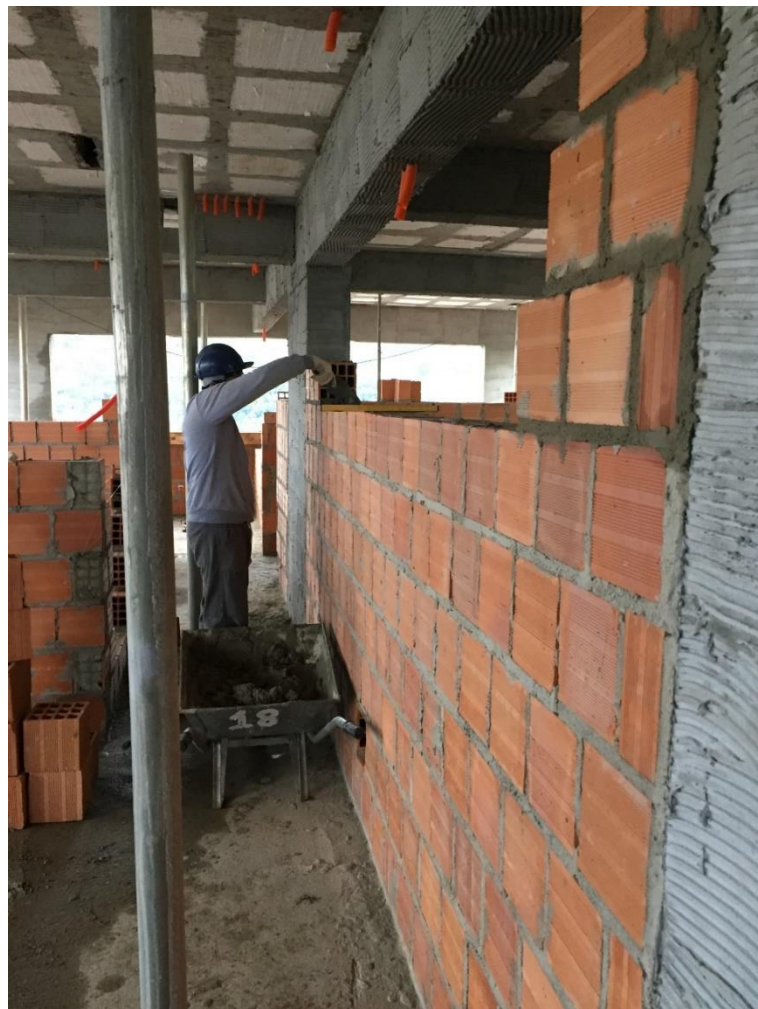
Figura 9: Elevação de alvenaria
