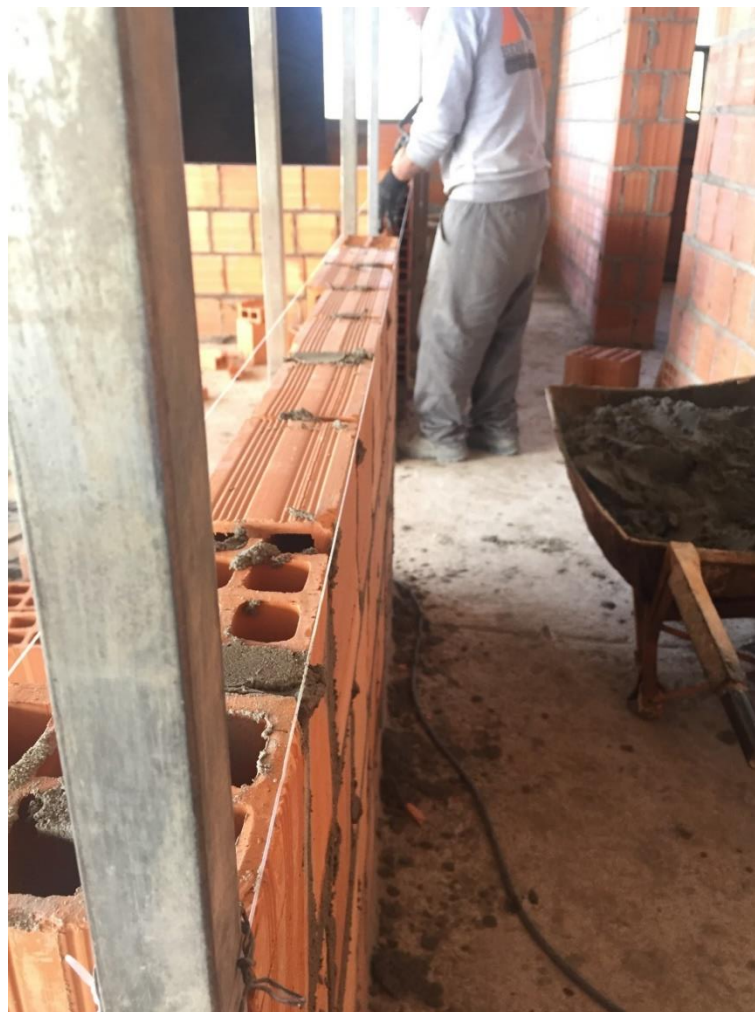
Figura 10: elevação de alvenaria
