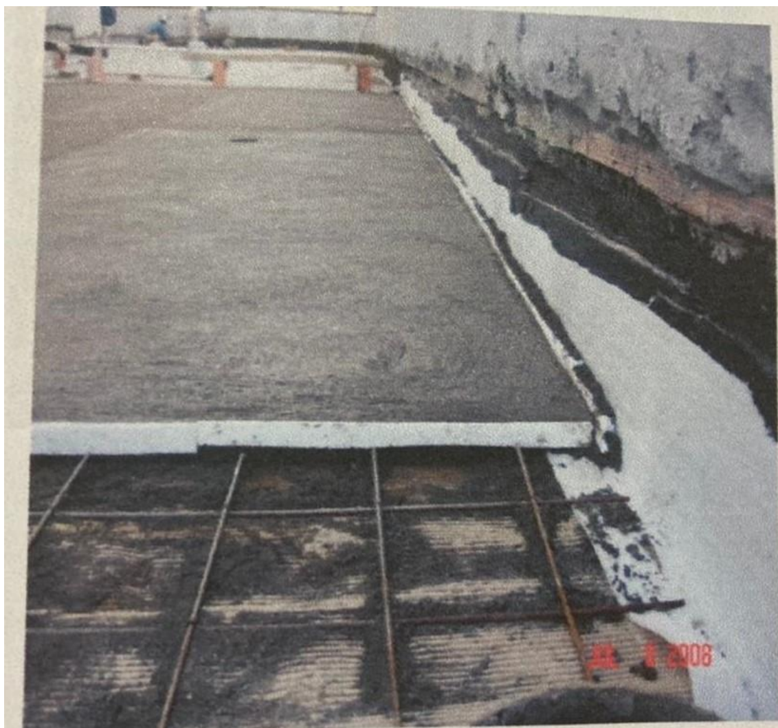
Figura 5: Execução de proteção mecânica
