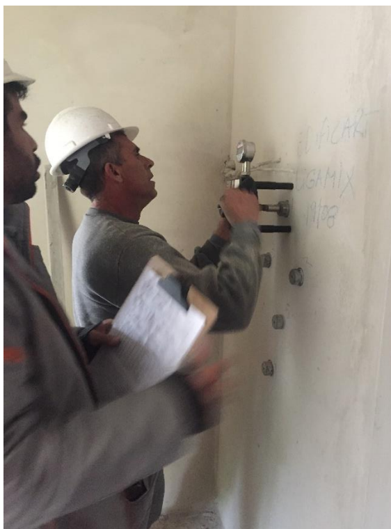
Figura 14: Teste de arrancamento
