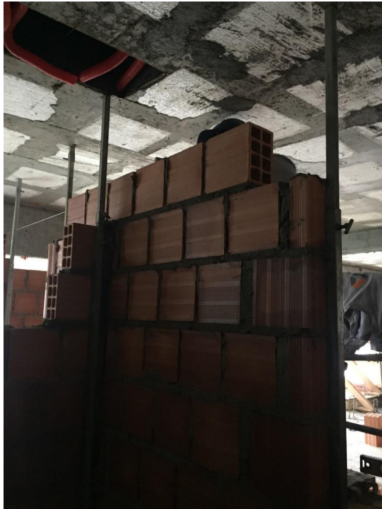
Figura 12: Uso do escantilhão na alvenaria
