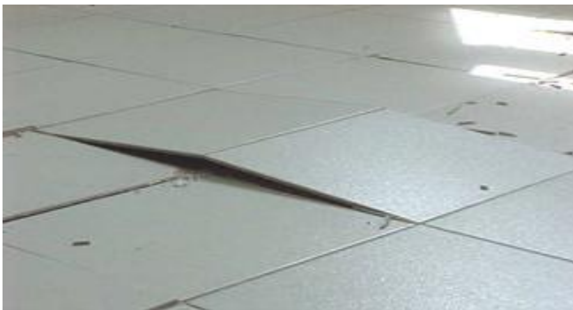
Figura 26. Dilatação térmica em piso cerâmico (UNAMA, 2009)
