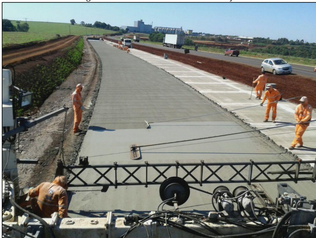
Figura 14 – Placas de concreto em execução
