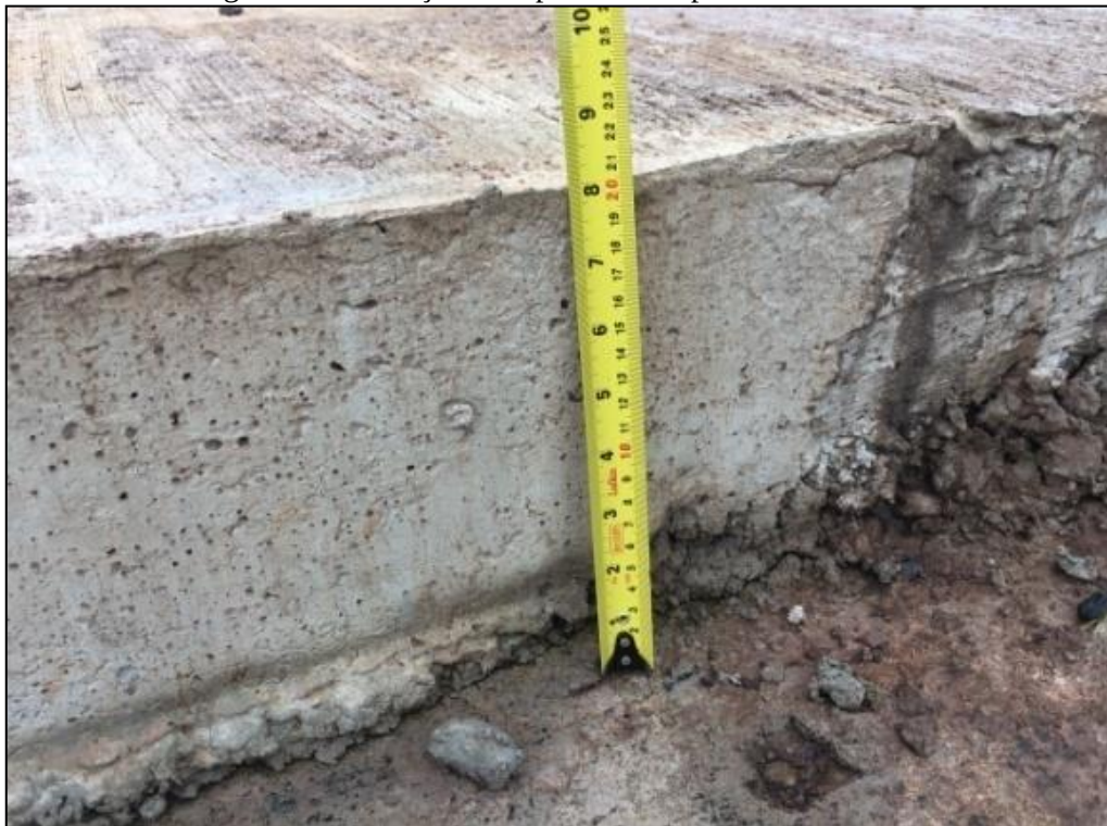
Figura 20 – Medição da espessura das placas de concreto
