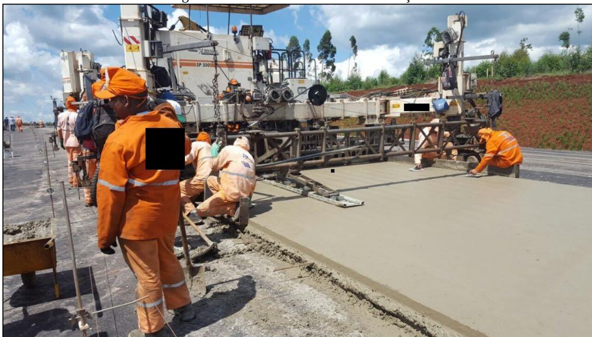
Figura 13 – Placas de concreto em execução
