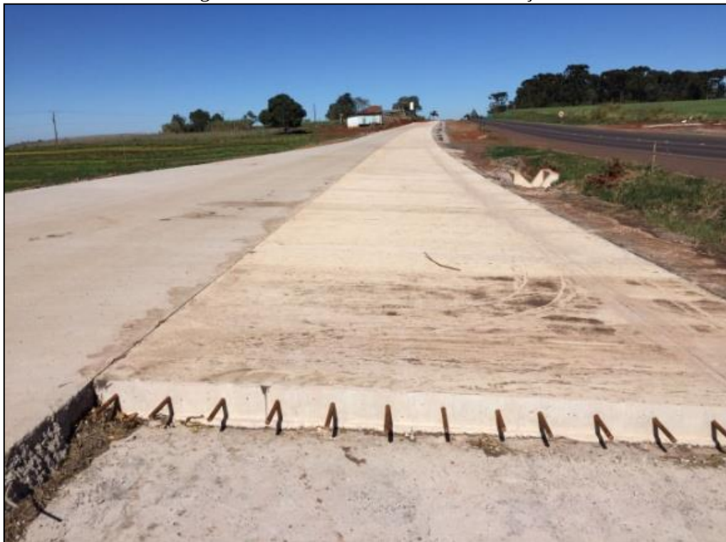
Figura 16 – Placas de concreto em execução
