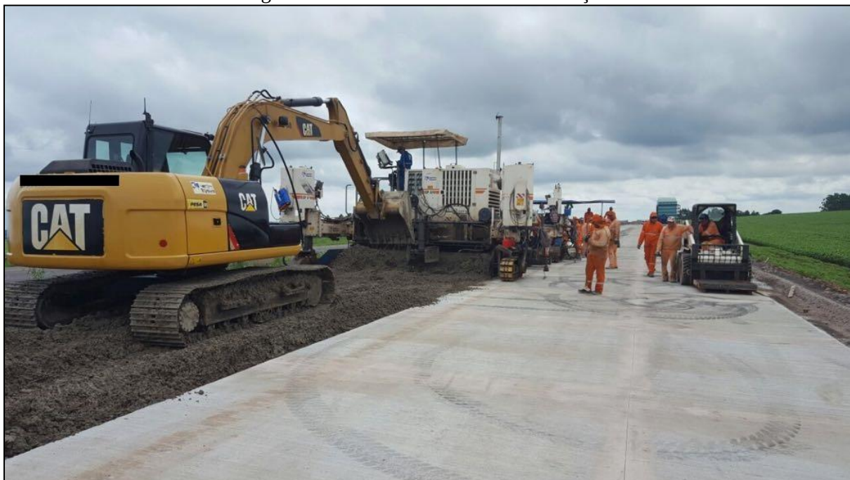
Figura 10 – Placas de concreto em execução
