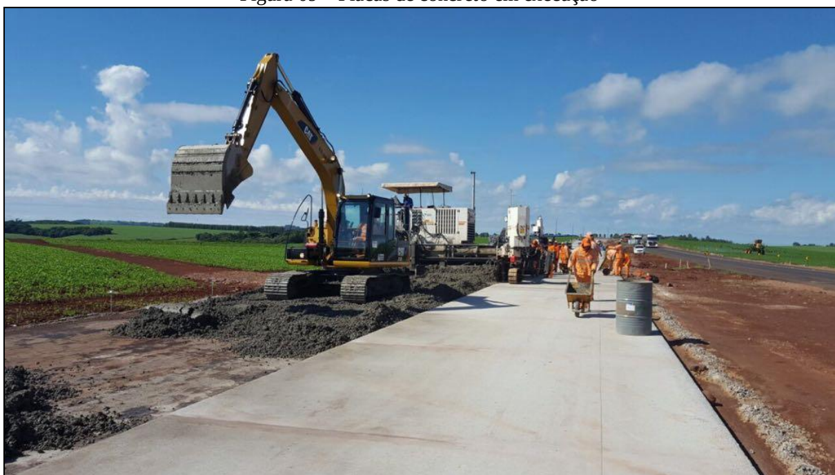
Figura 09 – Placas de concreto em execução
