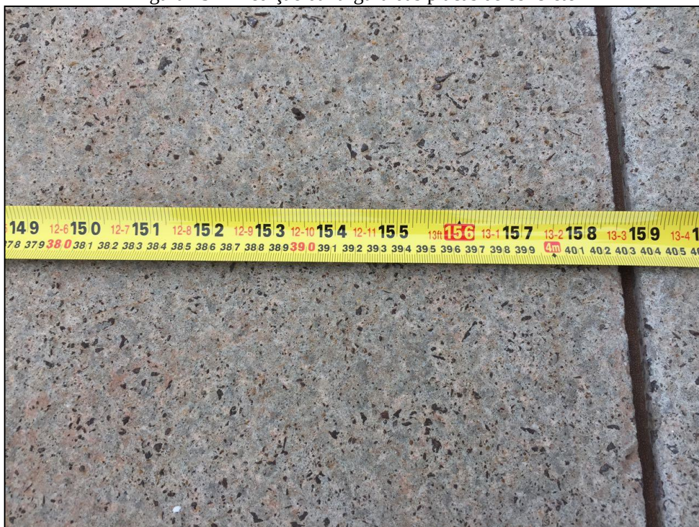
Figura 19 – Medição da largura das placas de concreto
