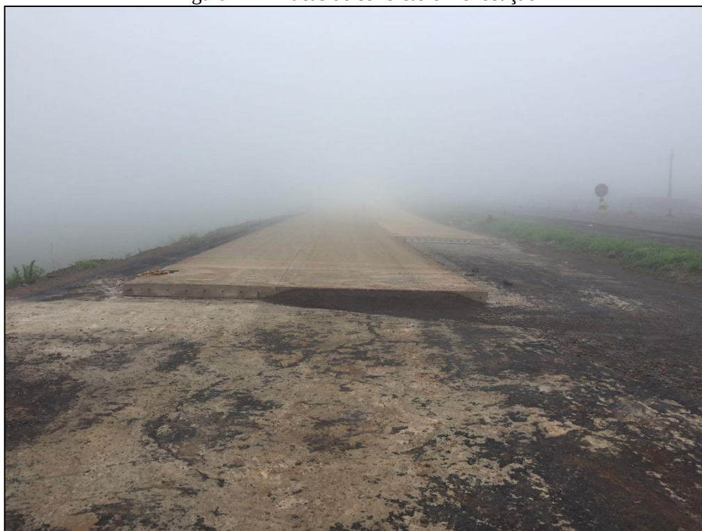
Figura 17 – Placas de concreto em execução
