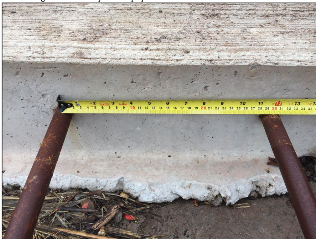
Figura 21 – Medição do espaçamento entre as barras de transferência
