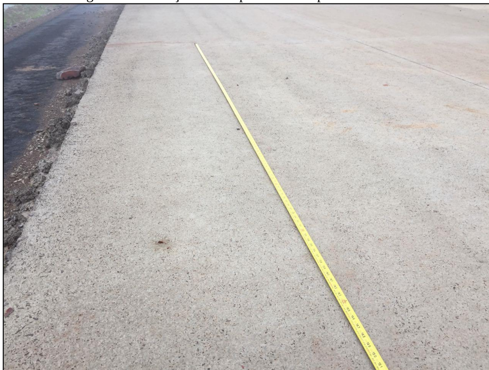
Figura 18 – Medição do comprimento das placas de concreto
