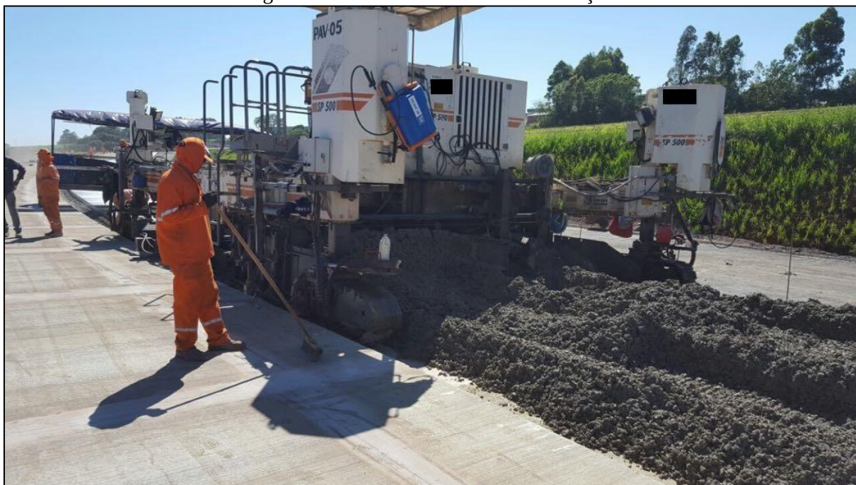
Figura 11 – Placas de concreto em execução
