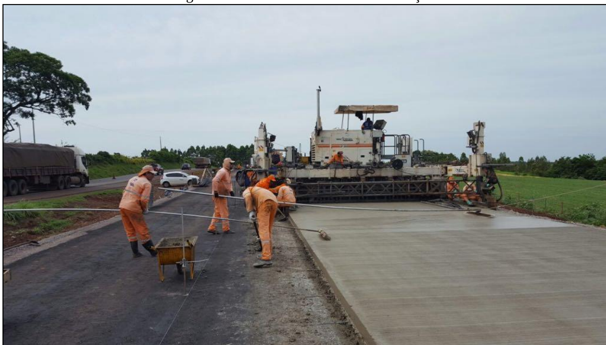
Figura 15 – Placas de concreto em execução
