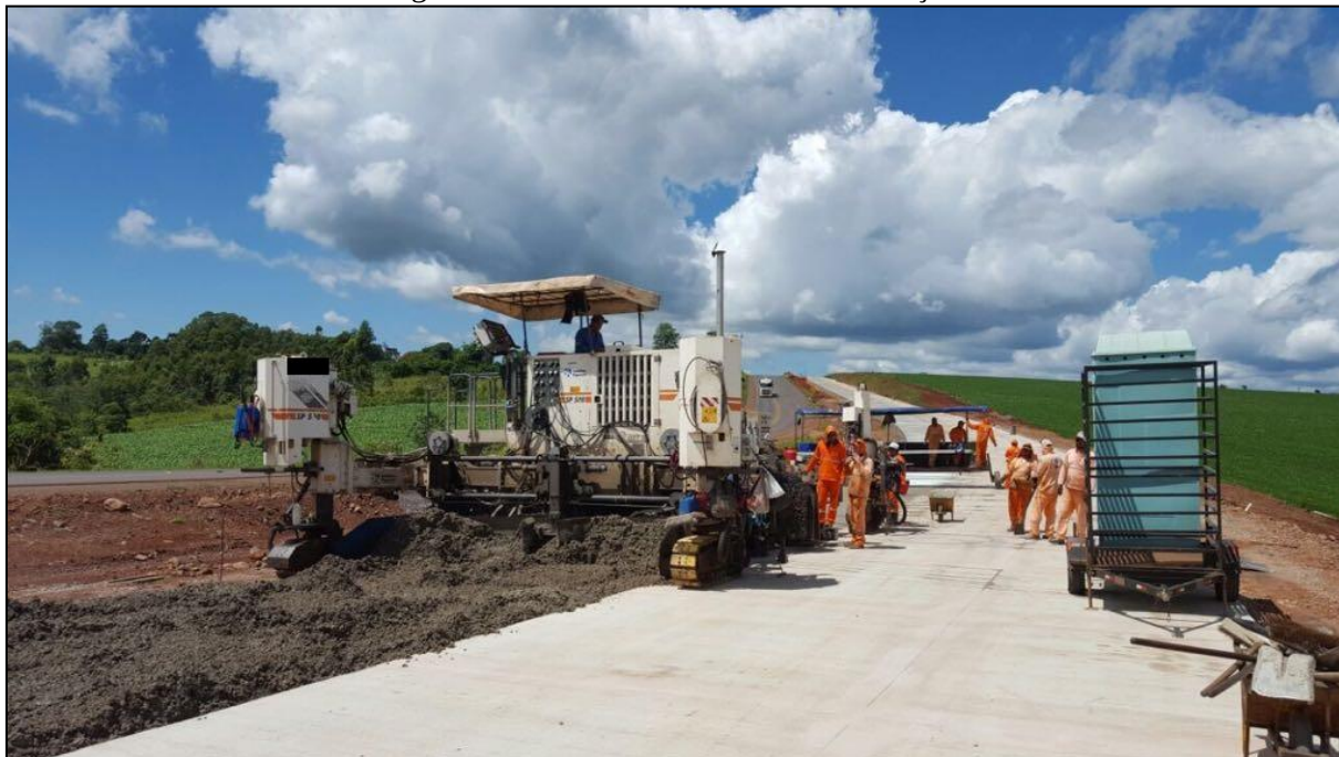
Figura 12 – Placas de concreto em execução
