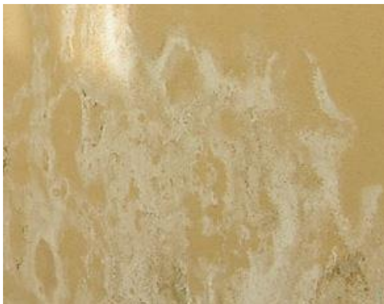
Figure 9 - Calcinação - Fonte: autores
