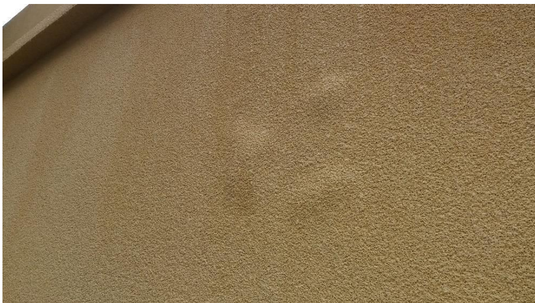
Figure 11 - Empolamento - Fonte: autores
