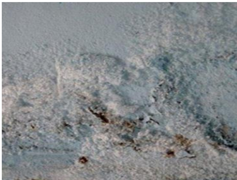
Figure 8 - Saponificação - Fonte: autores
