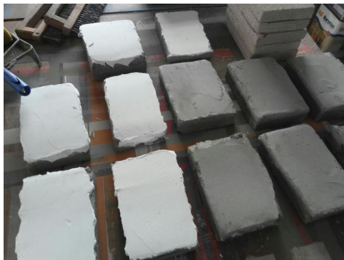
Figure 17 - Substratos preparados com e sem massa corrida. Fonte: Autores
