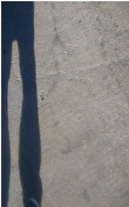
Figura 30 – Retração plástica – Grau de severidade baixo – Placa 29A
