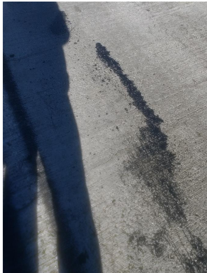
Figura 31 – Retração plástica – Grau de severidade baixo – Placa 45A
