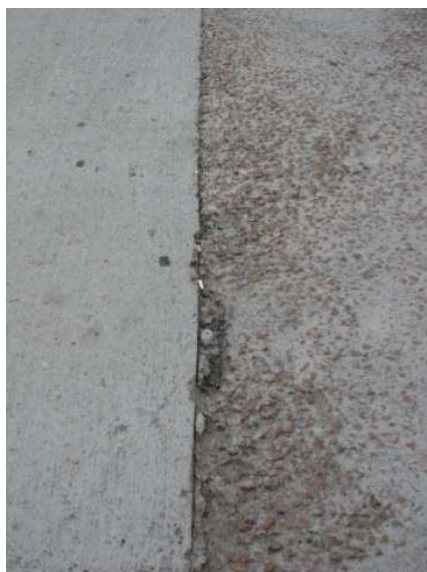
Figura 4 – Ilustração de desgaste superficial – Material de aula Profº Giublin
