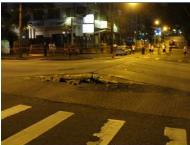
Figura 2 – Ilustração de Alçamento de placas – Fonte: Material de aula Profº:Giublin
