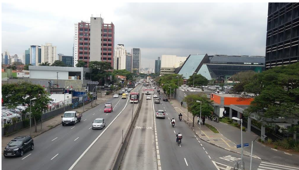
Figura 7: imagem da via de pavimento rígido onde foi realizado a vistoria – Fonte: http://mapio.net/s/29923585/ - acesso na data: 10/11/2017
