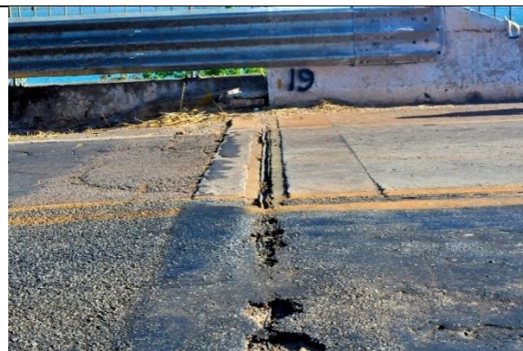
Manifestações Patológicas Encontradas: Fissuras no Pavimento, juntas de dilatação Deformadas e sem função.
