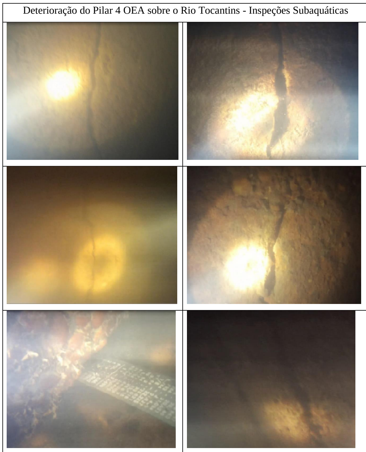
Quadro 33 - Inspeção Subaquática
