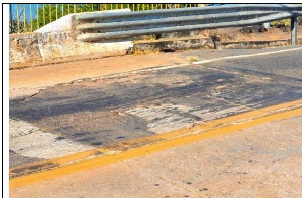
Manifestações Patológicas Encontradas: Fissuras no Pavimento, juntas de dilatação Deformadas e sem função.
