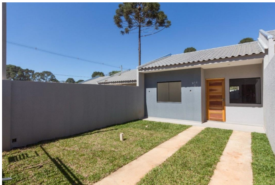
Figura 11 – Entrada da Residência Fonte: Os Autores (2018).
