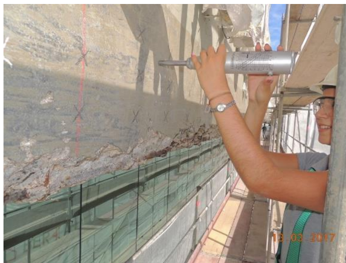
Figura 28. Execução do ensaio de Esclerometria (AUTORES, 2017)
