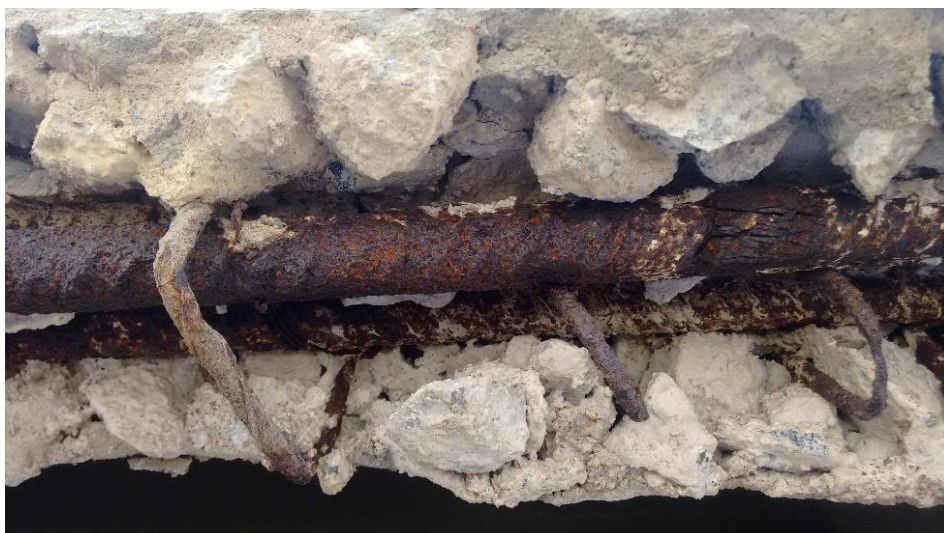
Figura 17. Manifestações patológicas identificadas nas platibandas (AUTORES, 2017)
