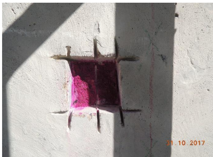
Figura 23. Ensaio de Carbonatação (AUTORES, 2017)
