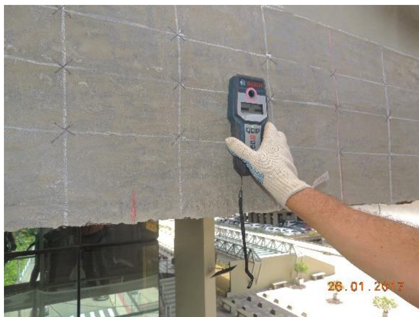
Figura 21. Execução do Ensaio de Pacometria (AUTORES, 2017)
