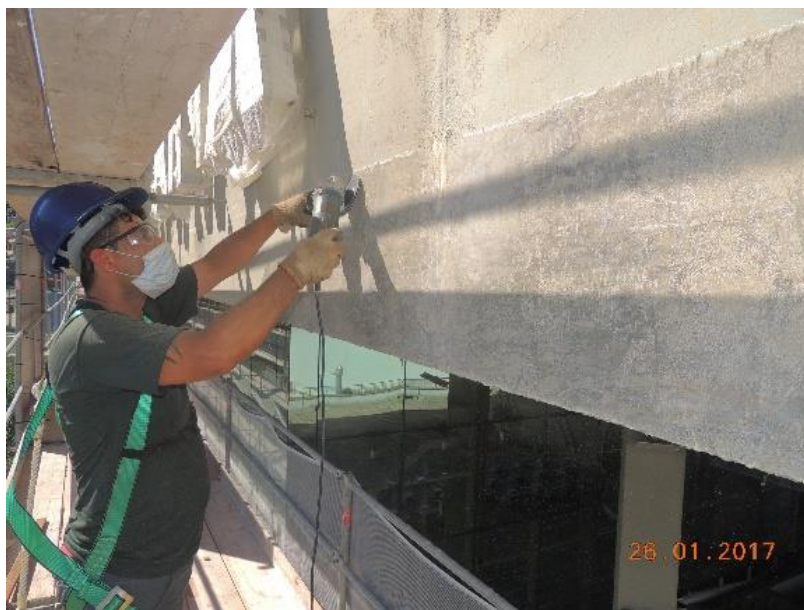
Figura 19. Lixação do revestimento da platibanda (AUTORES, 2017)
