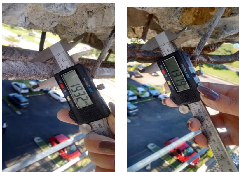
Figura 37. Medição da seção das armaduras (AUTORES, 2017)
