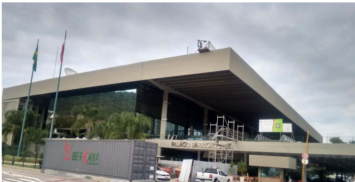
Figura 45. Fachadas nordeste e noroeste após a conclusão da obra (AUTORES, 2017)
