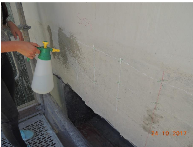
Figura 30. Umedecimento do local do Ensaio de Potencial de Corrosão (AUTORES, 2017)
