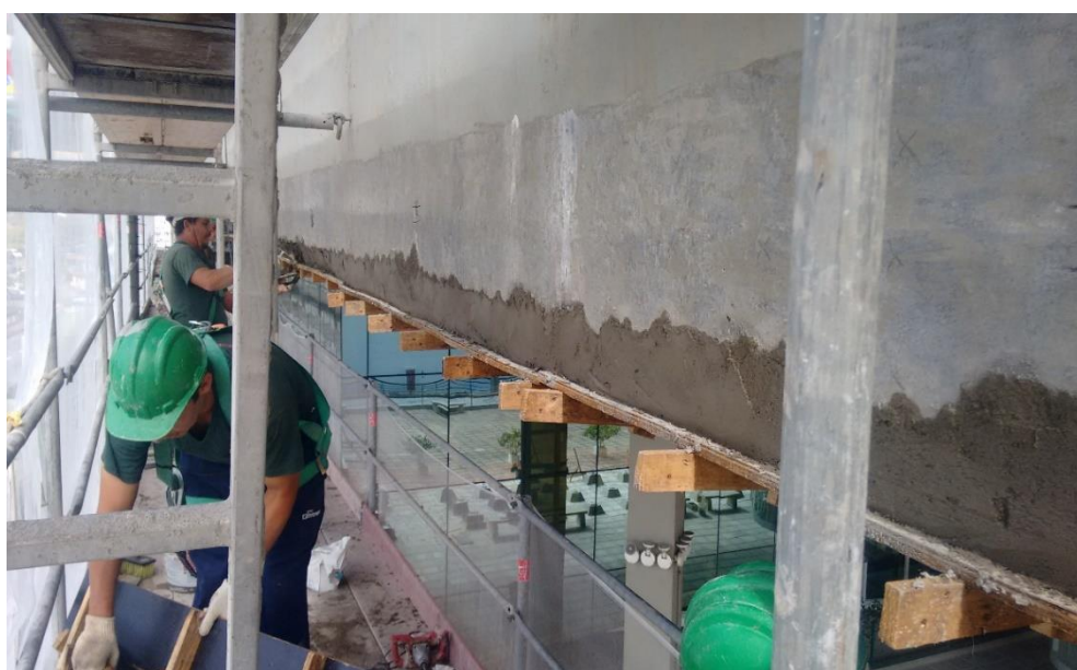
Figura 43. Aplicação de argamassa polimérica na Platibanda (AUTORES, 2017)
