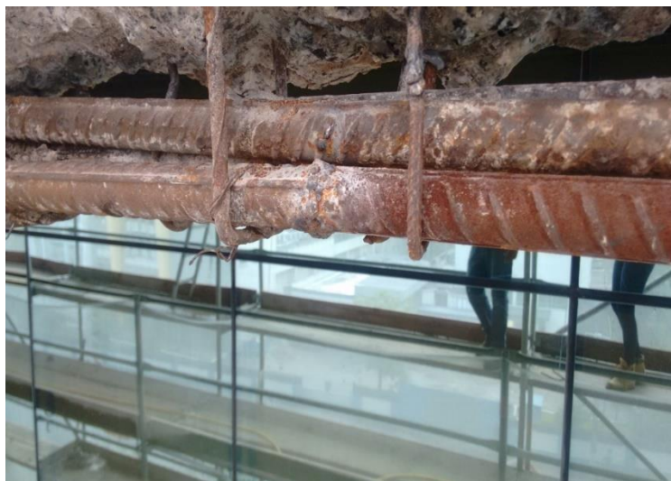
Figura 38. Armadura após substituição (AUTORES, 2017)
