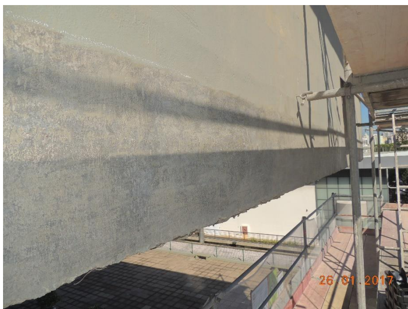
Figura 20. Revestimento da platibanda após lixação (AUTORES, 2017)
