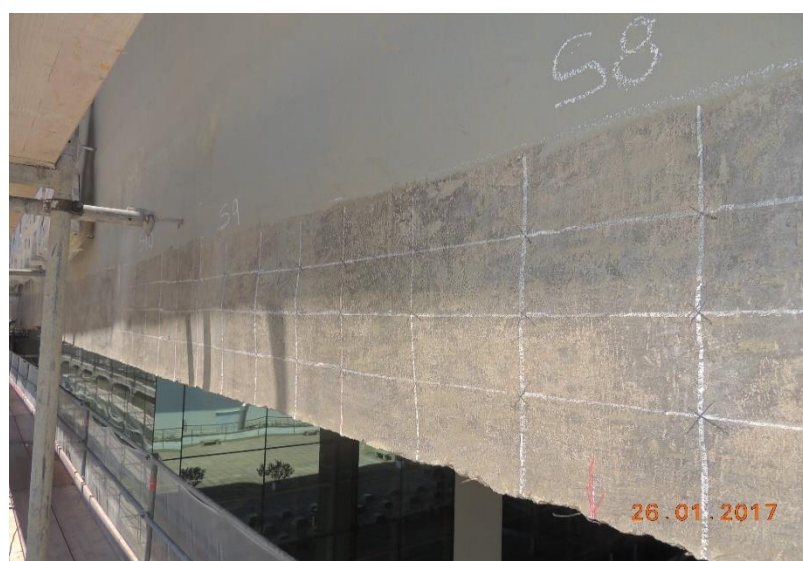
Figura 22. Marcação dos setores na platibanda (AUTORES, 2017)
