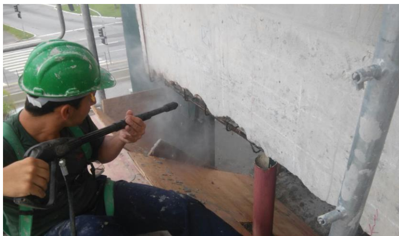
Figura 36. Jato de água Fria para limpeza da Platibanda (AUTORES, 2017)
