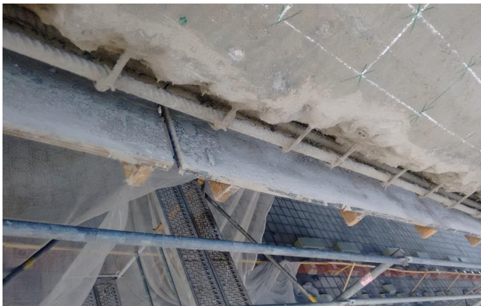
Figura 40. Aplicação de cimento modificado nas armaduras (AUTORES, 2017)
