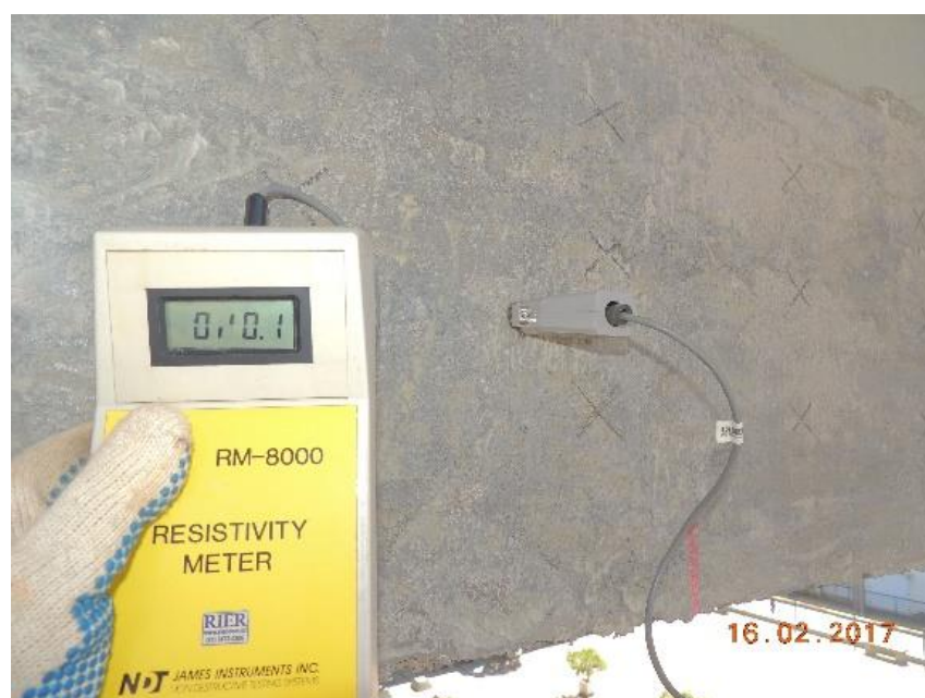
Figura 34. Execução do Ensaio de Resistividade Elétrica do Concreto (AUTORES, 2017)
