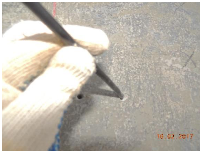
Figura 32. Execução dos furos para ensaio de resistividade elétrica do concreto (AUTORES, 2017)
