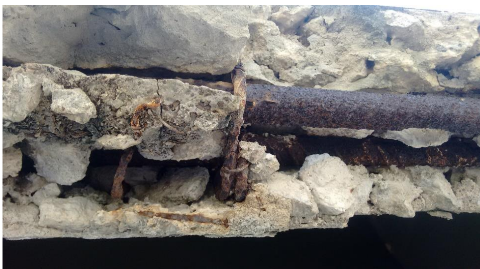
Figura 18. Manifestações patológicas identificadas nas platibandas (AUTORES, 2017)
