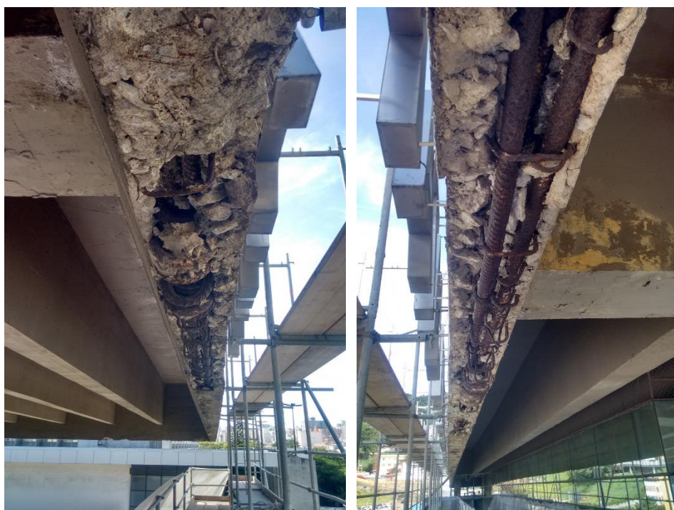
Figura 16. Manifestações patológicas identificadas nas platibandas (AUTORES, 2017)
