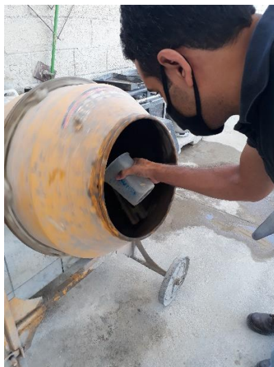
Figura 74 - Fabricação do Concreto.
