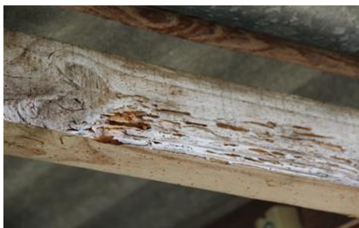
Figura 20. Ataque por Xilófagos (Cupins)
