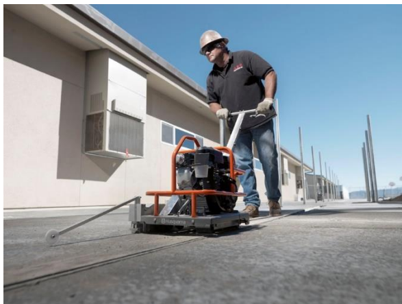
Figura 10 – Corte da junta com equipamento Soff-Cut
