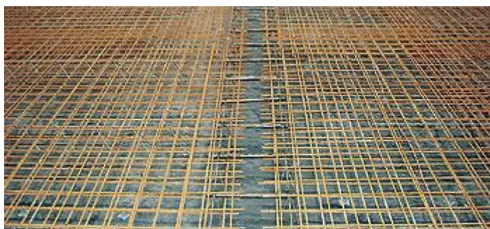
Figura 5 – Interrupção da armadura para a junta serrada
