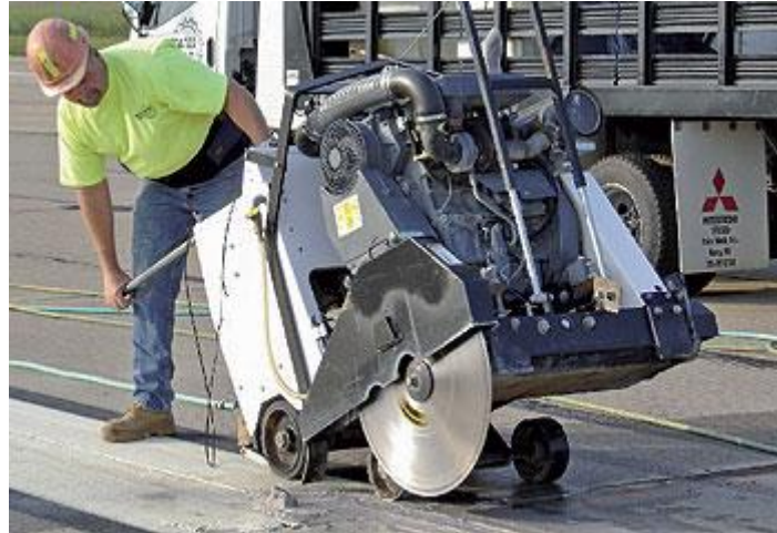
Figura 6 – Corte de junta serrada.
