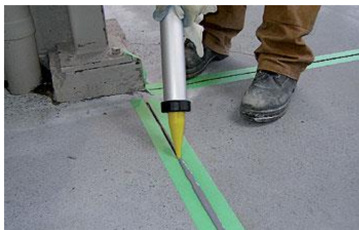
Figura 7 – Selamento de junta serrada.
