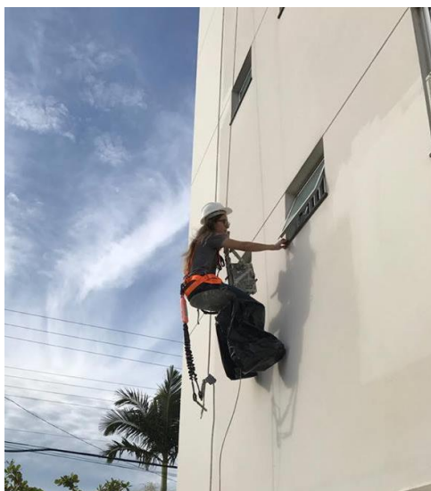
Figura 10: Vistoria física com cadeira suspensa por corda
