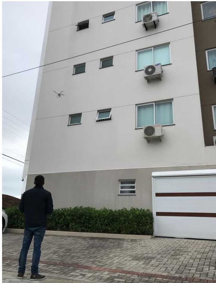
Figura 13: Vistoria com drone
