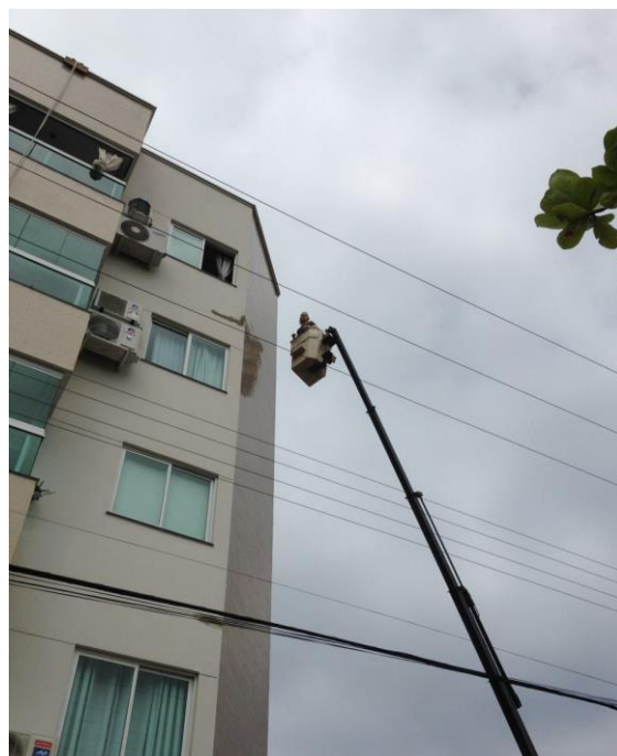
Figura 9: Utilização de caminhão guindaste para vistoria física.
