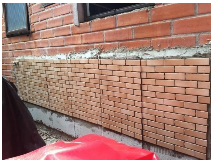
Figura 32. Aplicação de cerâmica
