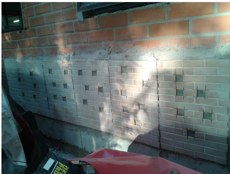
Foto 13. Painel geral final do ensaio: 36 pontos.
