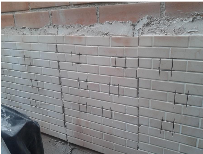
Foto 1. Corte da cerâmica.
