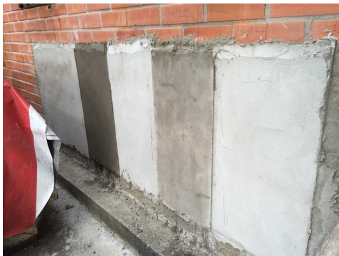
Figura 22. Aplicação de hidrofugante para tratamento superficial
