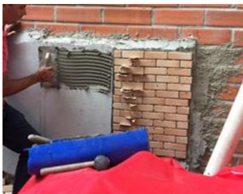
Figura 31. Aplicação de cerâmica
