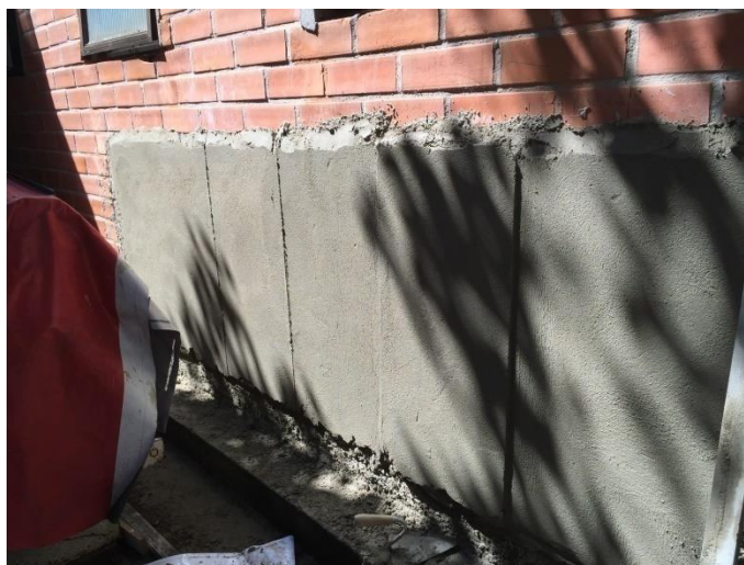
Figura 21. Aplicação da Massa Única nos painéis
