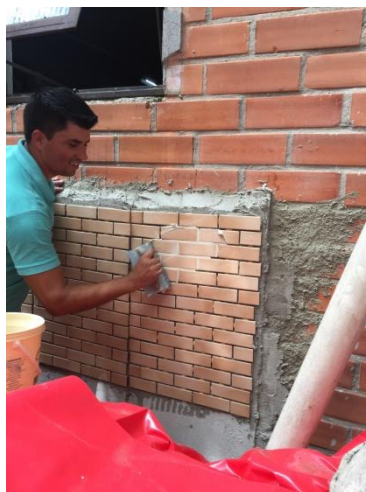
Figura 33. Aplicação de rejunte
