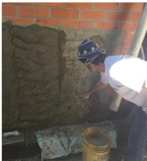
Figura 20. Aplicação da Massa Única nos painéis
