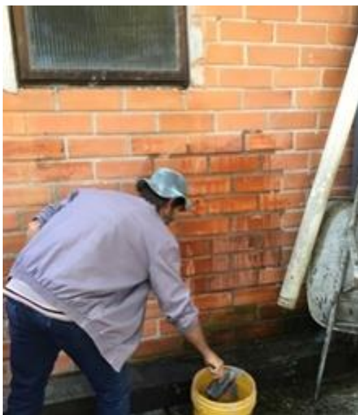
Figura 15. Limpeza e saturação de base
