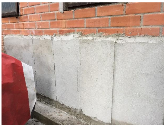
Figura 29. Limpeza de revestimento argamassado
