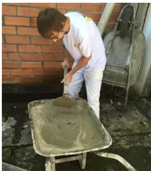
Figura 16. Chapisco em processo de mistura
