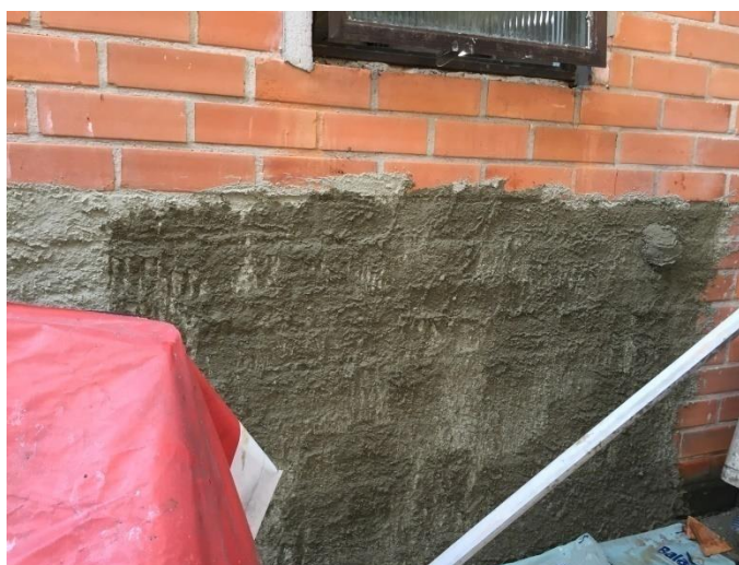
Figura 19. Saturação/Umedecimento da Base
