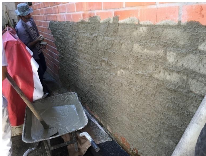
Figura 17. Aplicação de chapisco com colher
