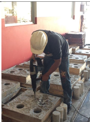
Foto 31. Retirada dos corpos de prova encamisados das caixas
