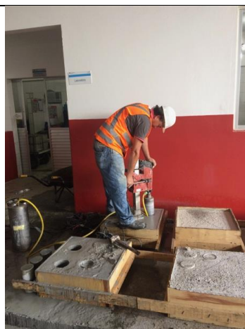
Foto 29. Extração dos testemunhos de concreto
