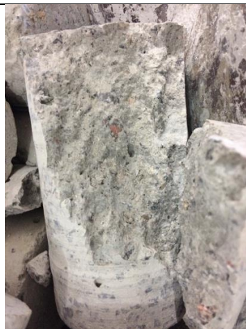
Foto 41. Testemunho classe C30 curado em água rompido à compressão
