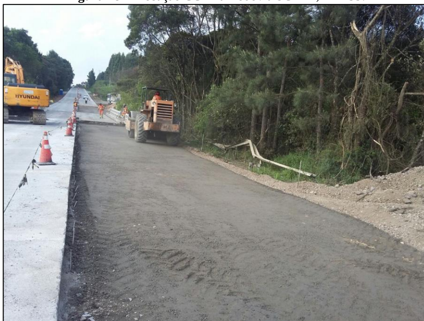
Figura 28 – Execução CCR na Rodovia SC-114, km 199.
