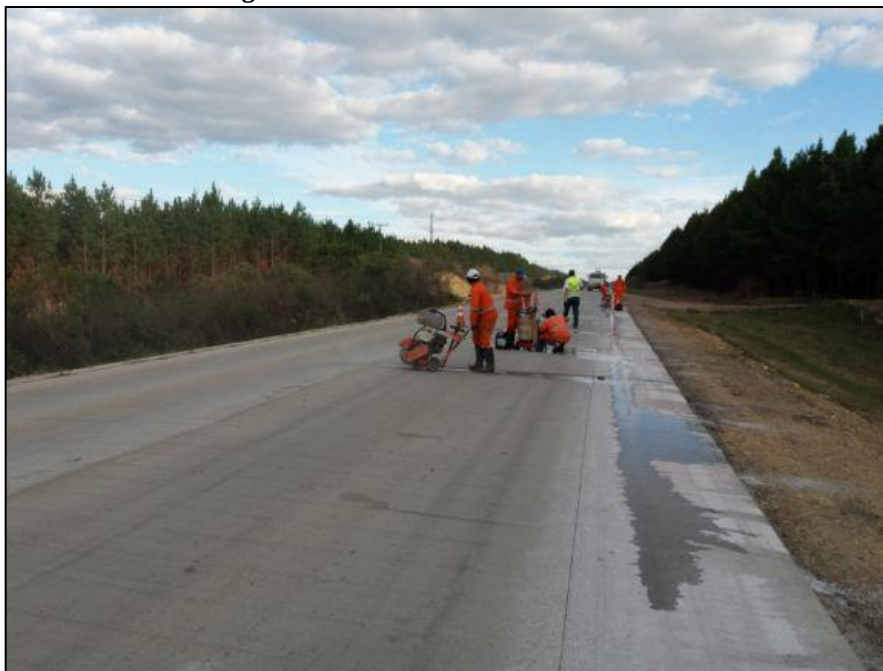
Figura 22 – Junta sendo serrada na SC-114.
