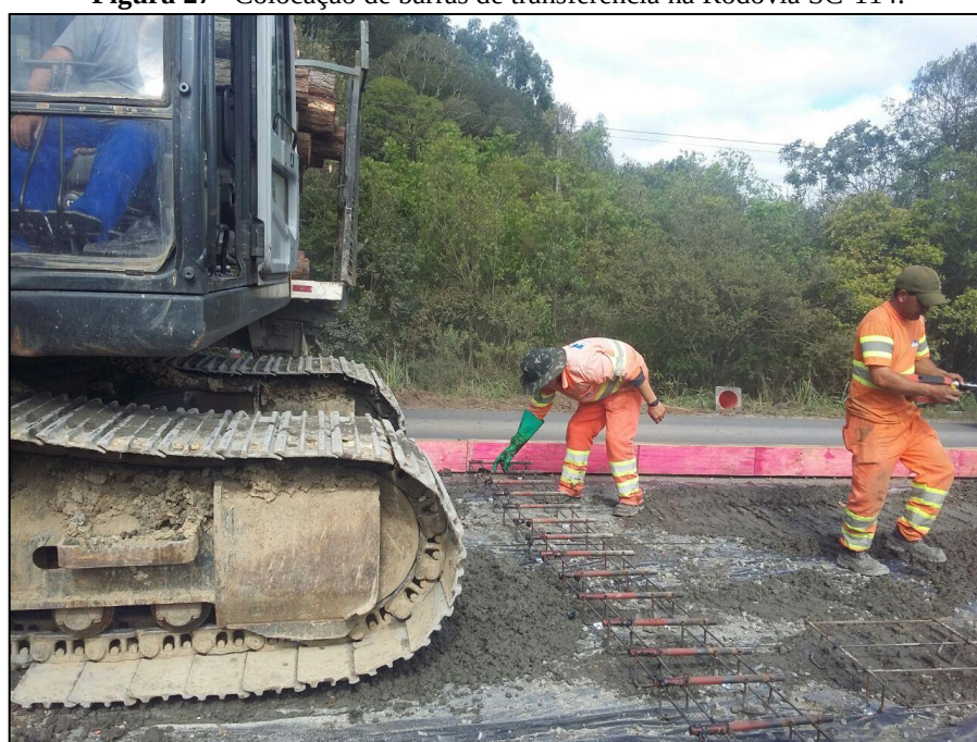
Figura 27 – Colocação de barras de transferência na Rodovia SC-114.
