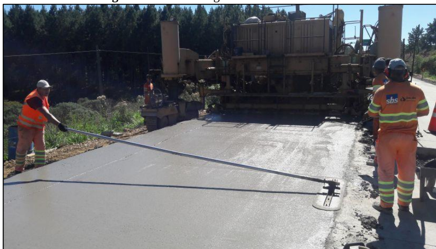
Figura 26 – Concretagem da Rodovia SC-114.
