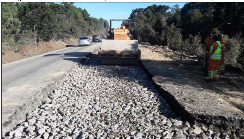
Figura 30 – Execução de remendo profundo em macadame seco na SC-114, km 211.
