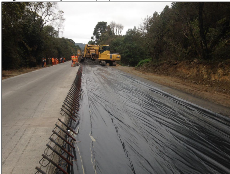
Figura 25 – Colocação de filme (lona) sobre o revestimento asfáltico da SC-114.
