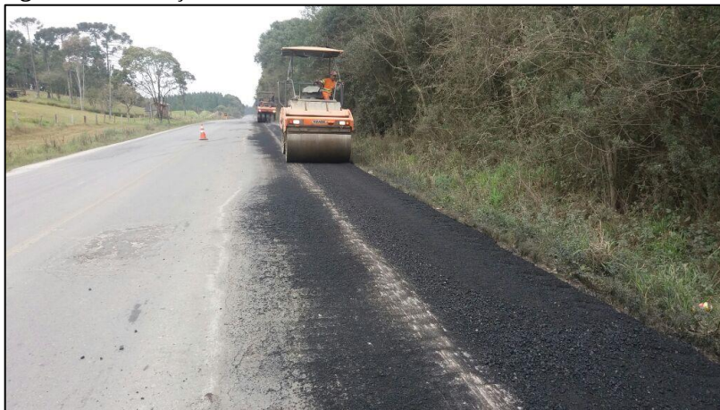
Figura 21 – Execução de camada de nivelamento no acostamento da SC-114.
