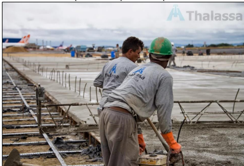
Figura 18 – Piso de concreto protendido no pátio do Aeroporto Afonso Pena – Curitiba/PR
