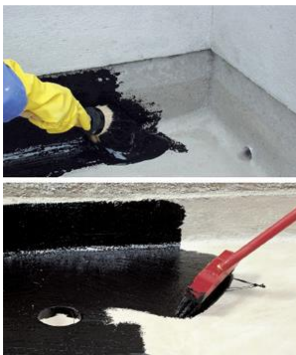
Figura 3 - Exemplo de aplicação de impermeabilizantes (MOREIRA, 2020).
