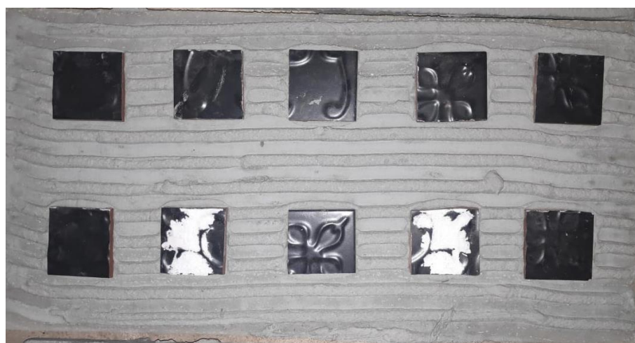
Figura 20 - Assentamento do revestimento cerâmico com absorção de água entre 3,0% e 6,0% Fonte: Os autores (2021).
