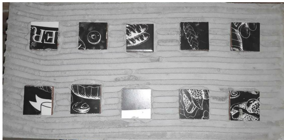
Figura 19 - Assentamento do revestimento cerâmico com absorção de água entre 0,5% e 3,0% Fonte: Os autores (2021).
