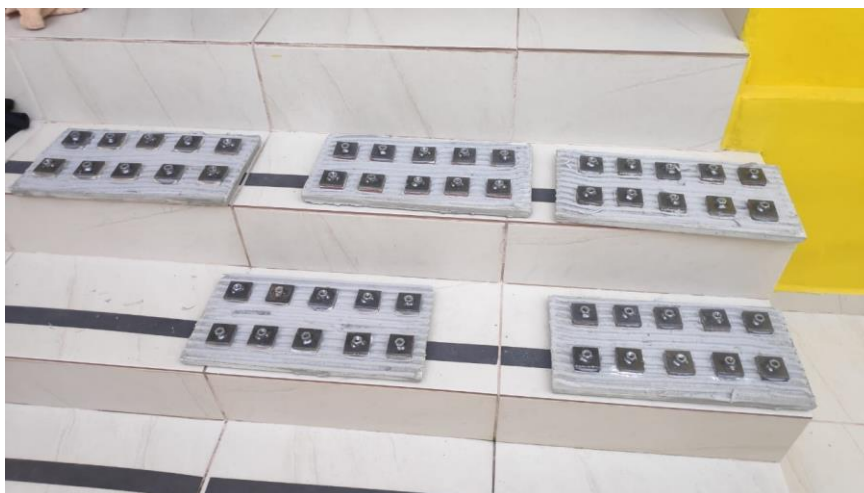
Figura 23 - Pastilhas de arrancamento coladas no revestimento cerâmico Fonte: Os autores (2021).
